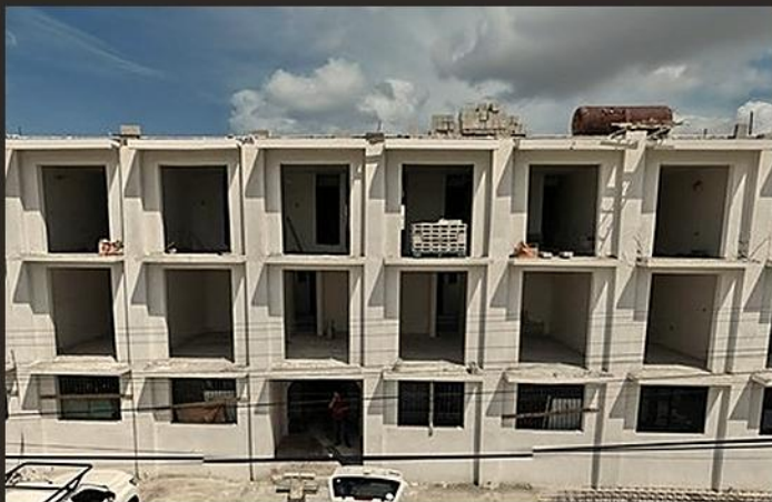
Fachada, avance de obra
