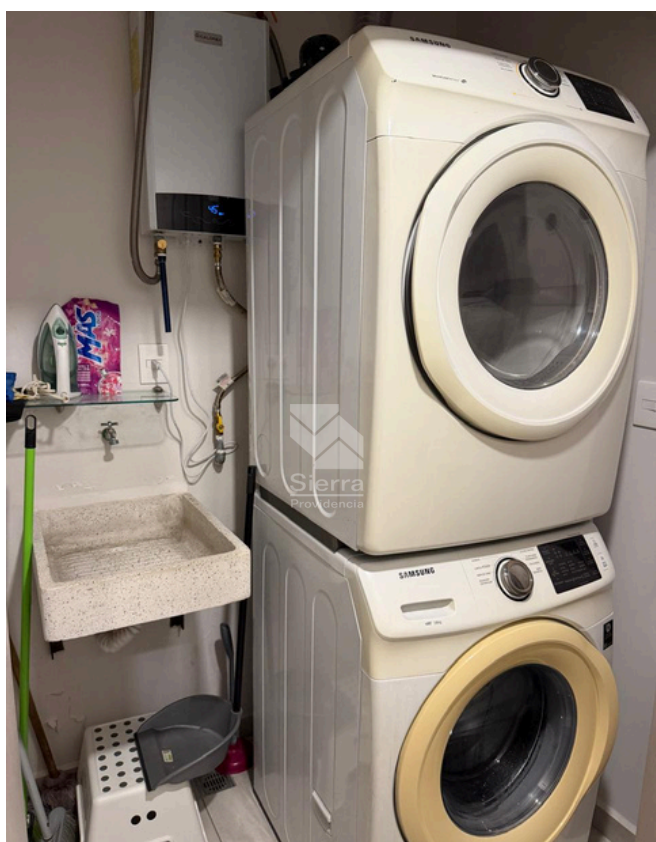
AREA DE LAVADO SEGUNDA SECCIÓN
