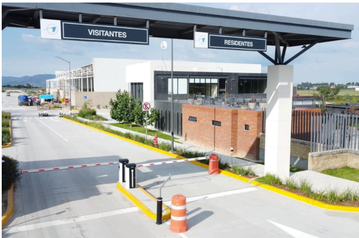
INGRESO A PARQUE INDUSTRIAL
