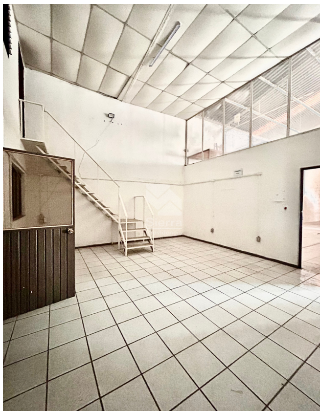
ESCALERAS A SEGUNDO NIVEL
