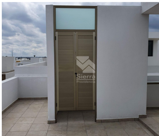
Tinaco e hidro
