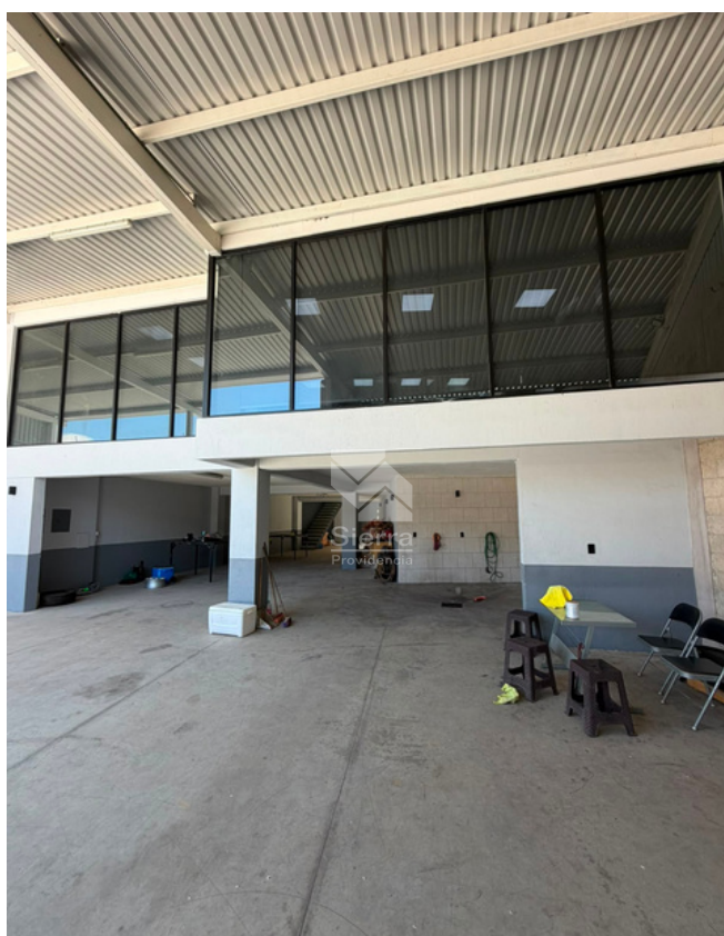
VISTA DE OFICINAS
