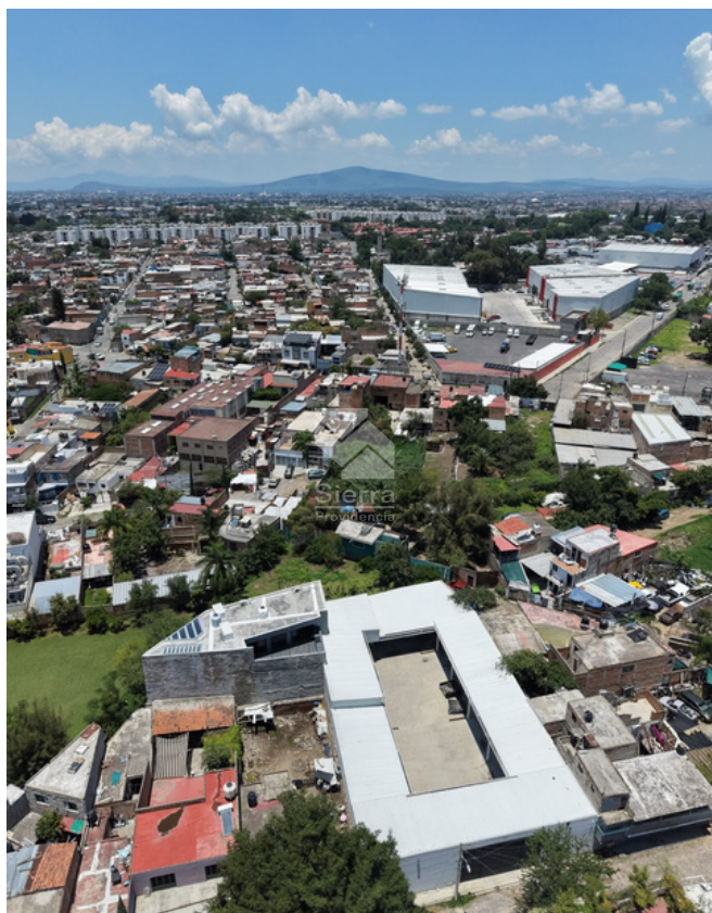
VISTA AEREA DE BODEGA
