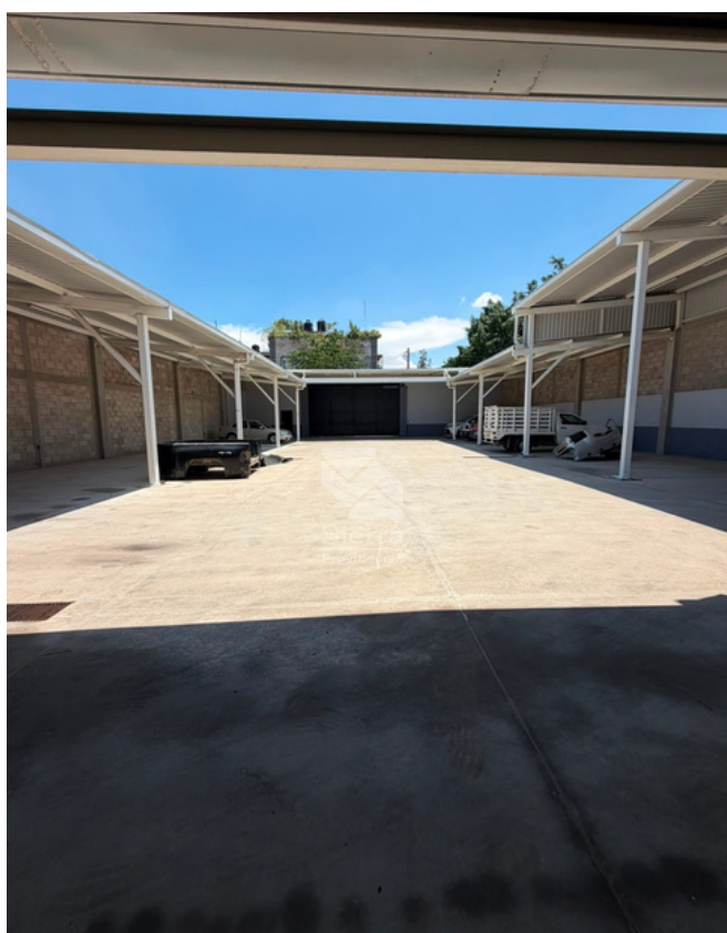
PATIO DE MANIOBRAS
