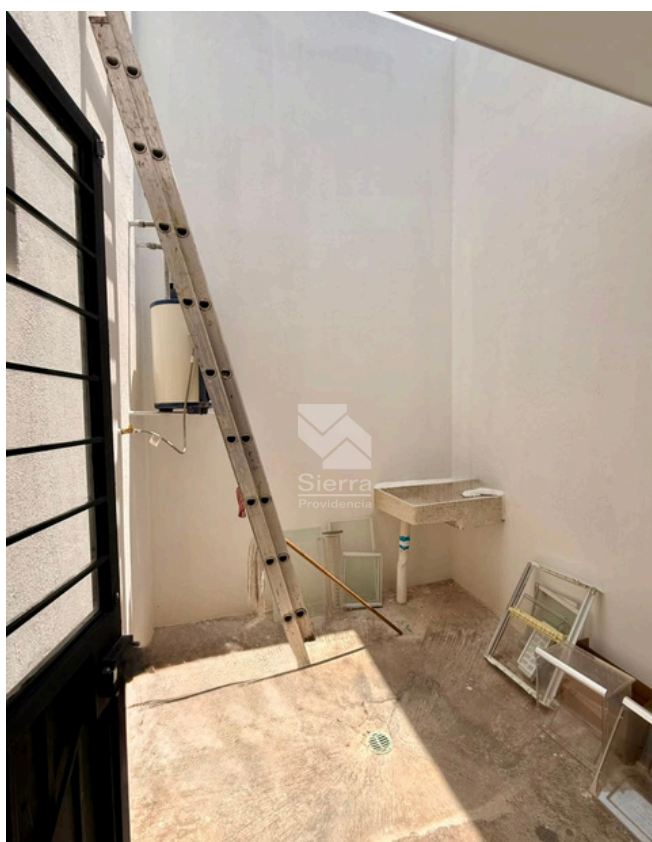
PATIO - ÁREA DE LAVADO
