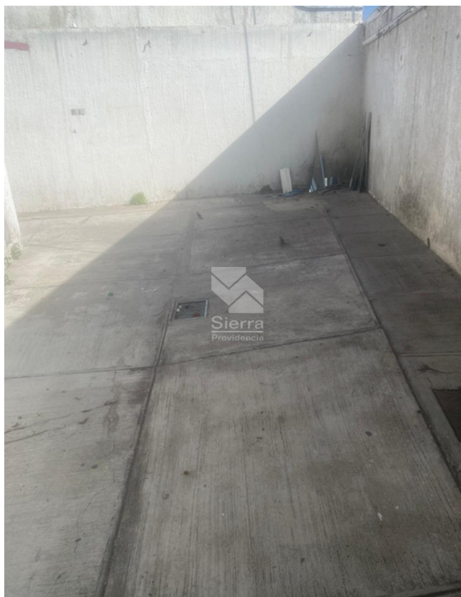
VISTA PARCIAL DE LA CONSTRUCCIÓN
