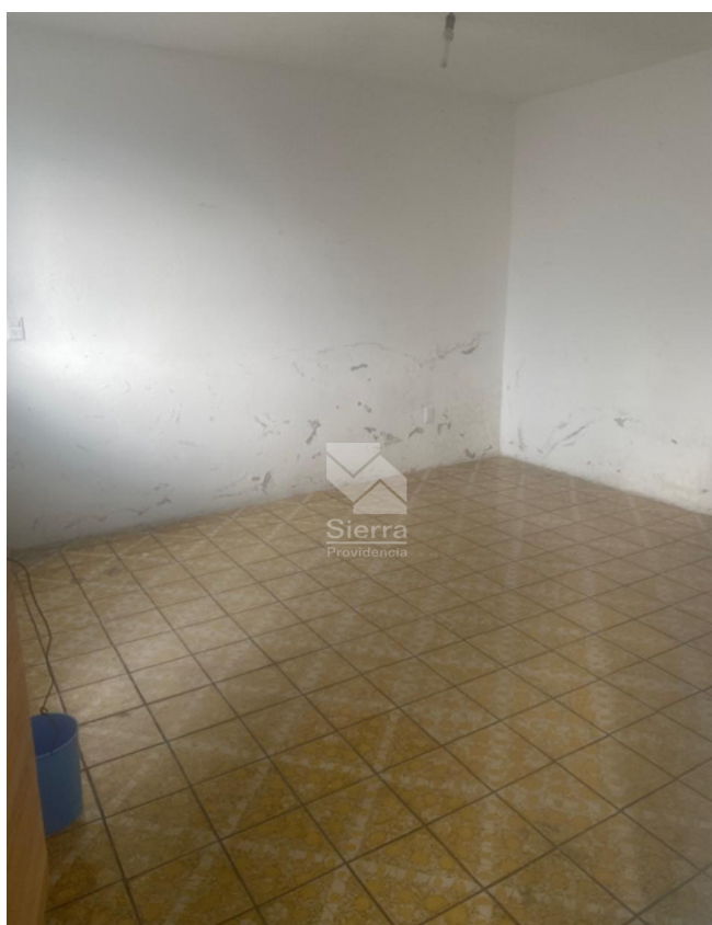
VISTA PARCIAL DE LA CONSTRUCCIÓN
