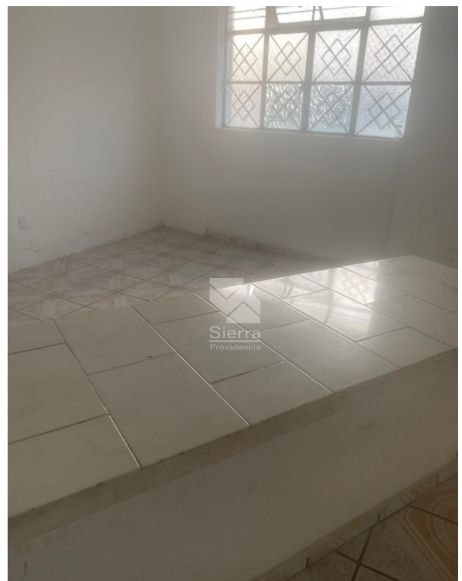
VISTA PARCIAL DE LA CONSTRUCCIÓN
