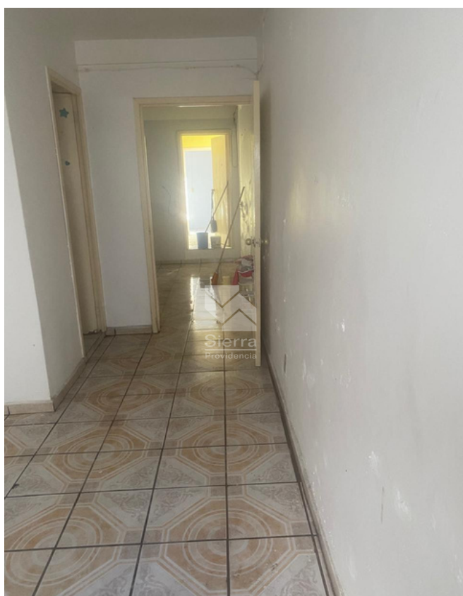
VISTA PARCIAL DE LA CONSTRUCCIÓN
