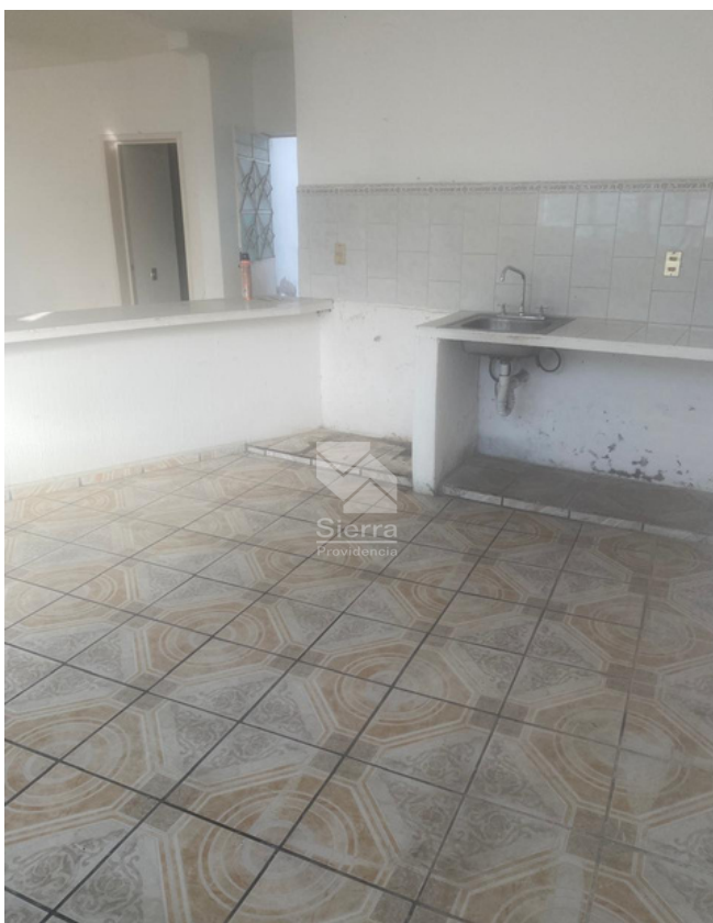
VISTA PARCIAL DE LA CONSTRUCCIÓN
