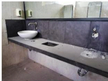
T-3: AREA DE BAÑOS
