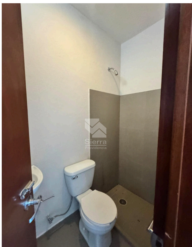
BAÑO RECÁMARA PLANTA BAJA
