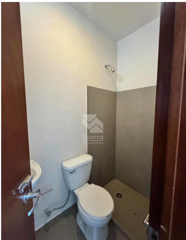
BAÑO RECÁMARA PLANTA BAJA
