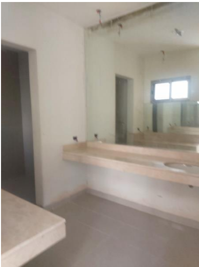
Área de lavabos en recámara
