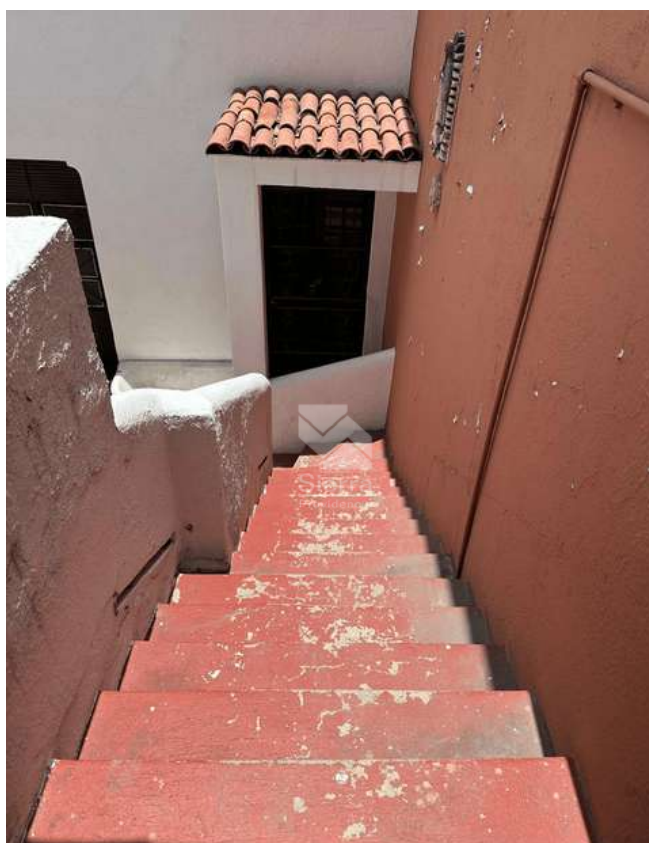
ESCALERAS A AZOTEA
