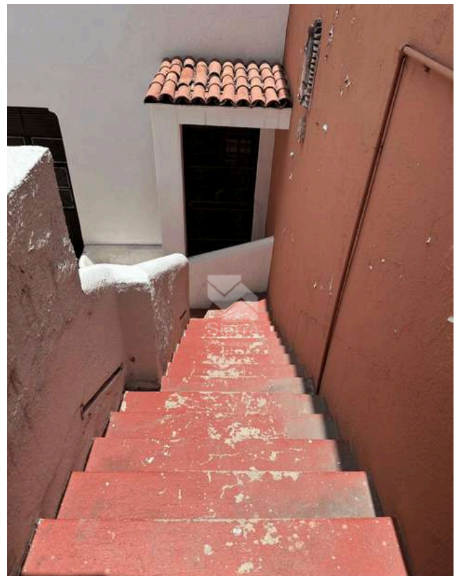
ESCALERAS A AZOTEA
