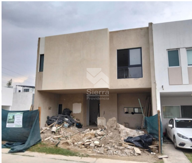
AVANCE DE OBRA - FACHADA
