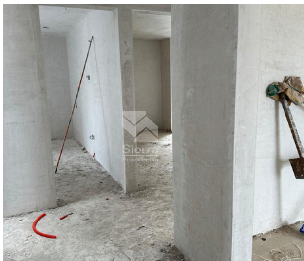
AVANCE DE OBRA - DISTRIBUIDOR
