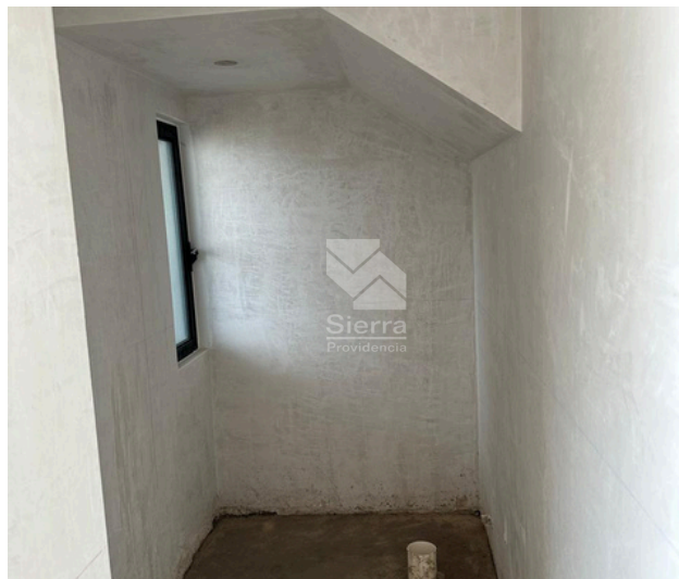
AVANCE DE OBRA - MEDIO BAÑO
