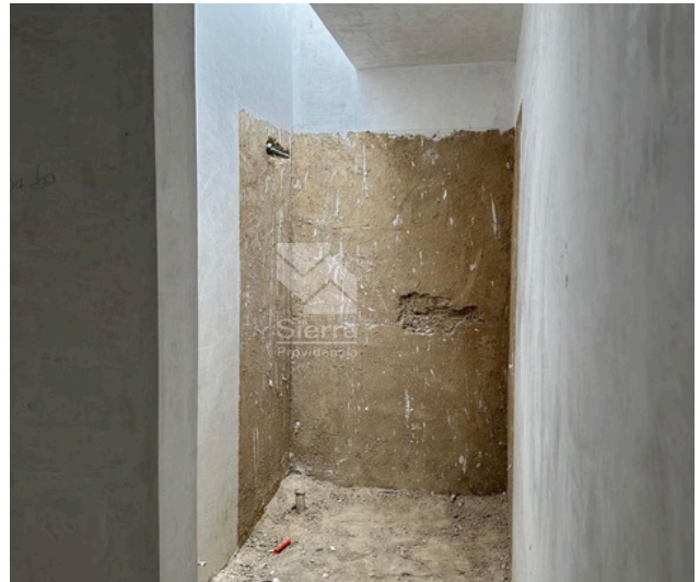
AVANCE DE OBRA - BAÑO COMPLETO
