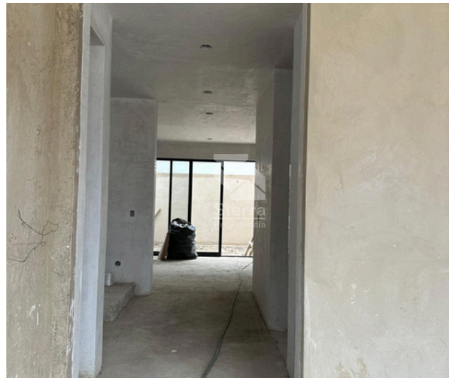
AVANCE DE OBRA - INGRESO
