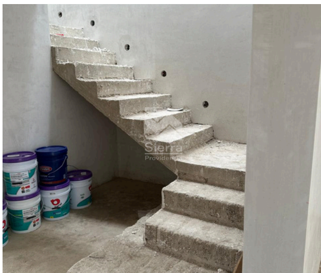
AVANCE DE OBRA - ESCALERAS
