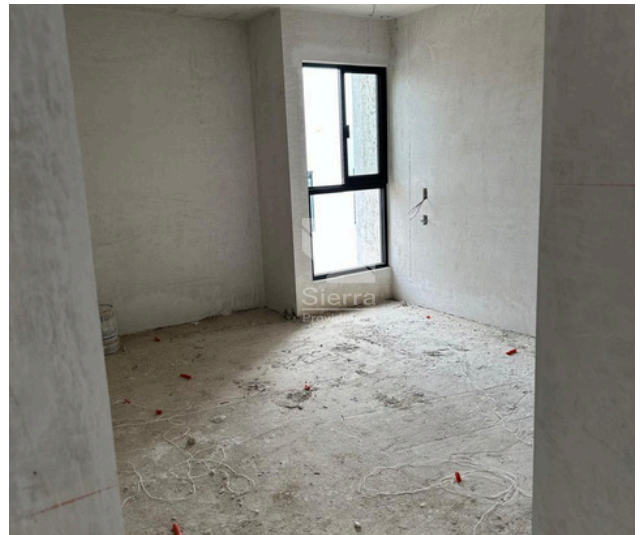
AVANCE DE OBRA - RECAMARA 2
