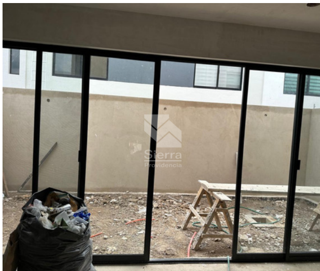
AVANCE DE OBRA - TERRAZA - JARDIN
