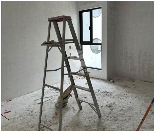
AVANCE DE OBRA - RECAMARA 3
