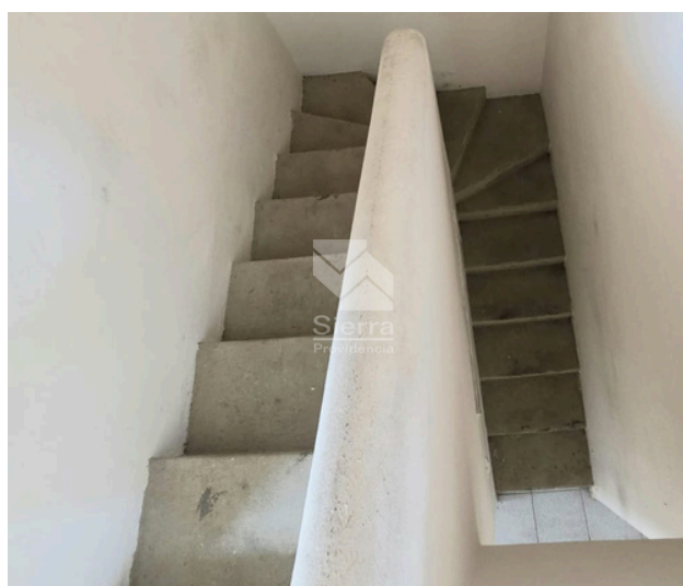
ESCALERAS DE SERVICIO
