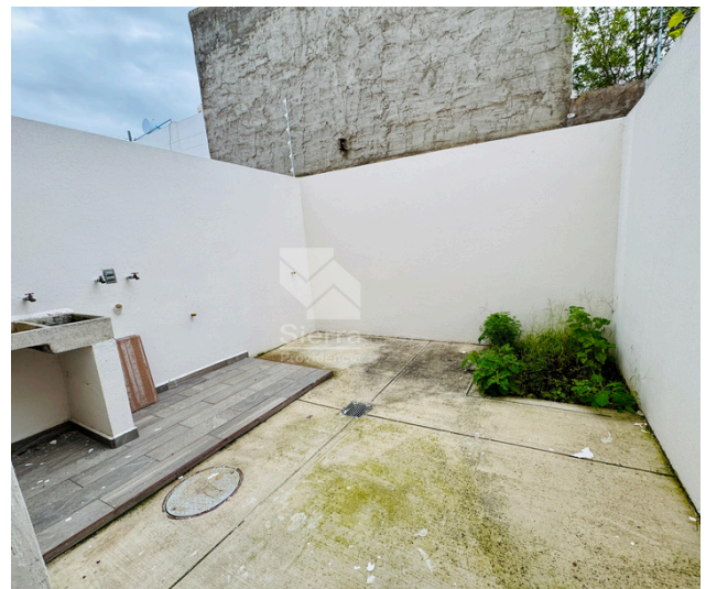
PATIO - ÁREA DE LAVADO
