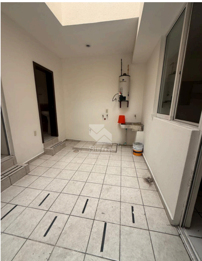
PATIO - ÁREA DE LAVADO
