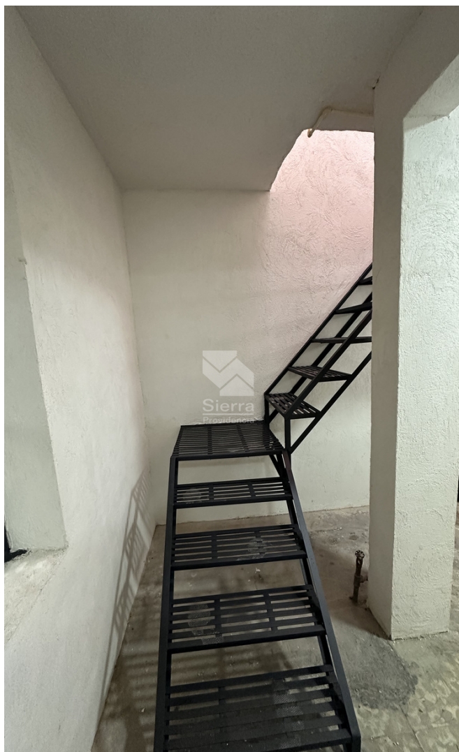
ESCALERAS A SEGUNDO NIVEL
