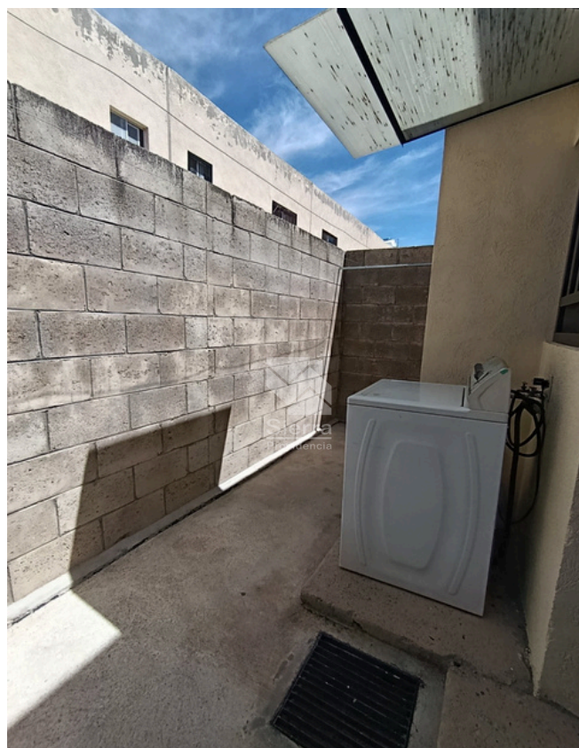
PATIO - ÁREA DE LAVADO
