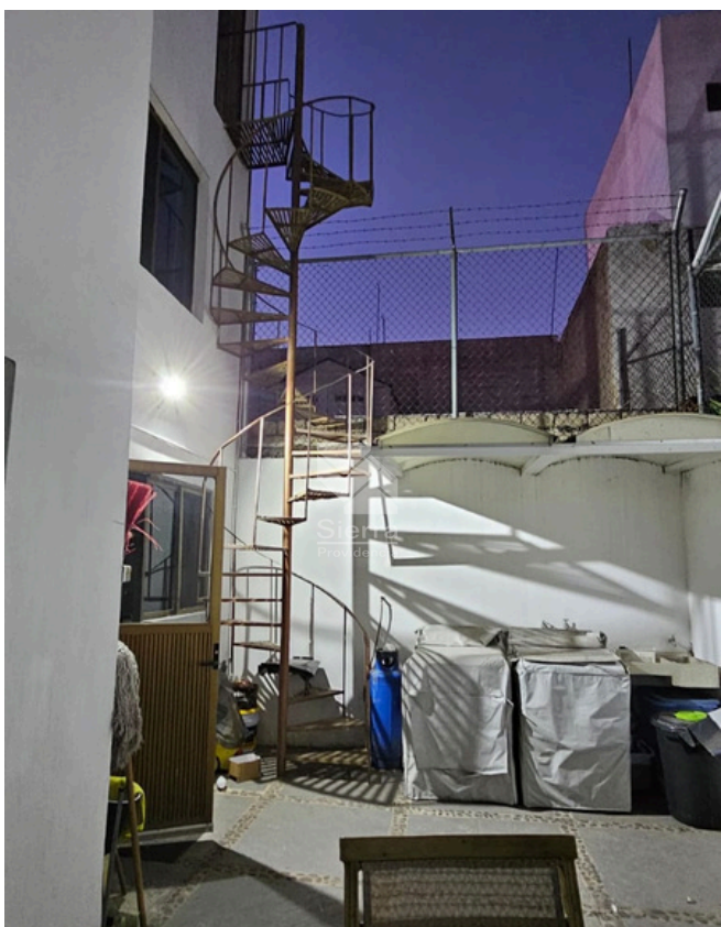
INGRESO A 3ER NIVEL
