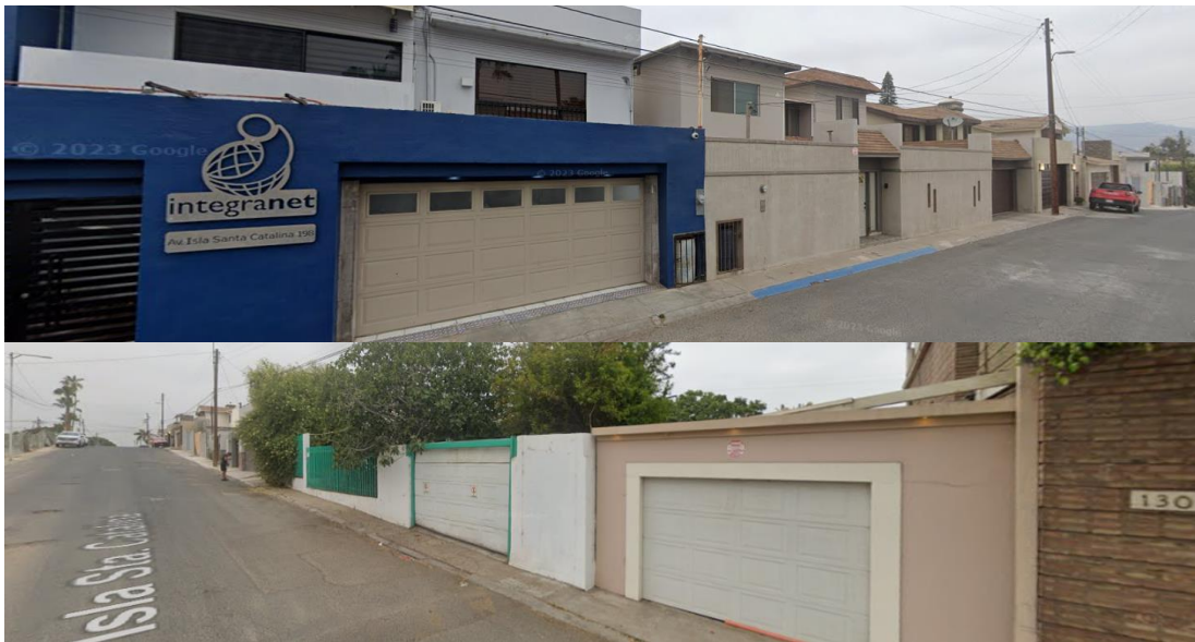
Figura 3: Vista a la colindancia oeste.
