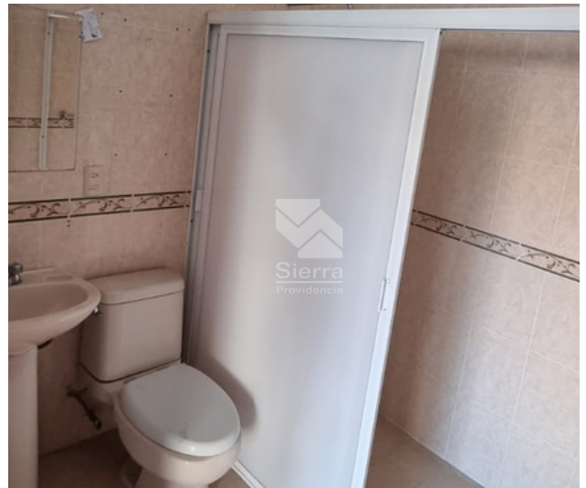
BAÑO CUARTO DE SERVICIO
