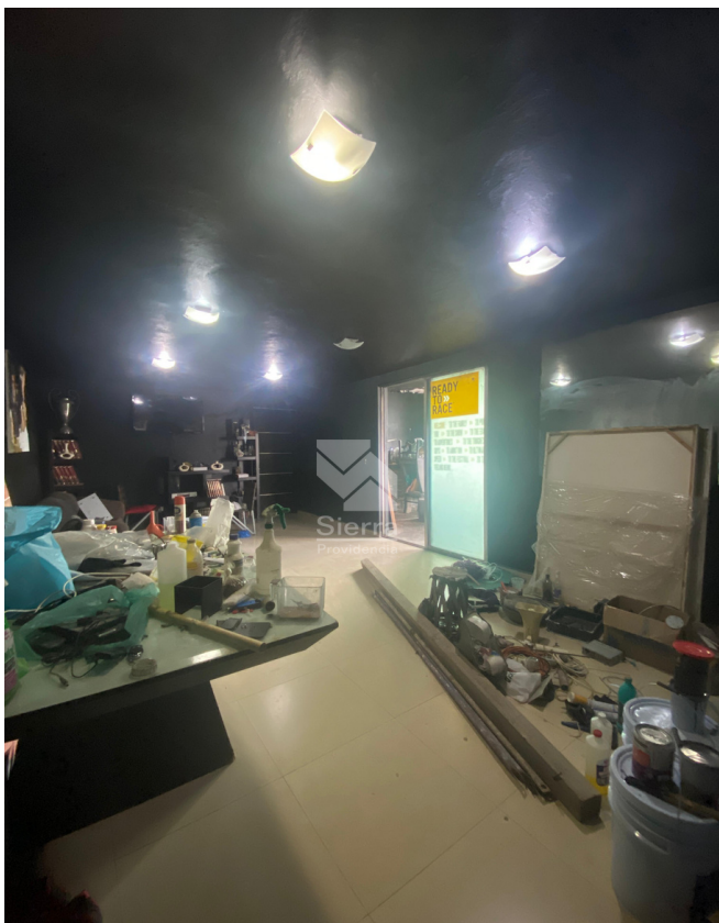
INGRESO A TERCER NIVEL
