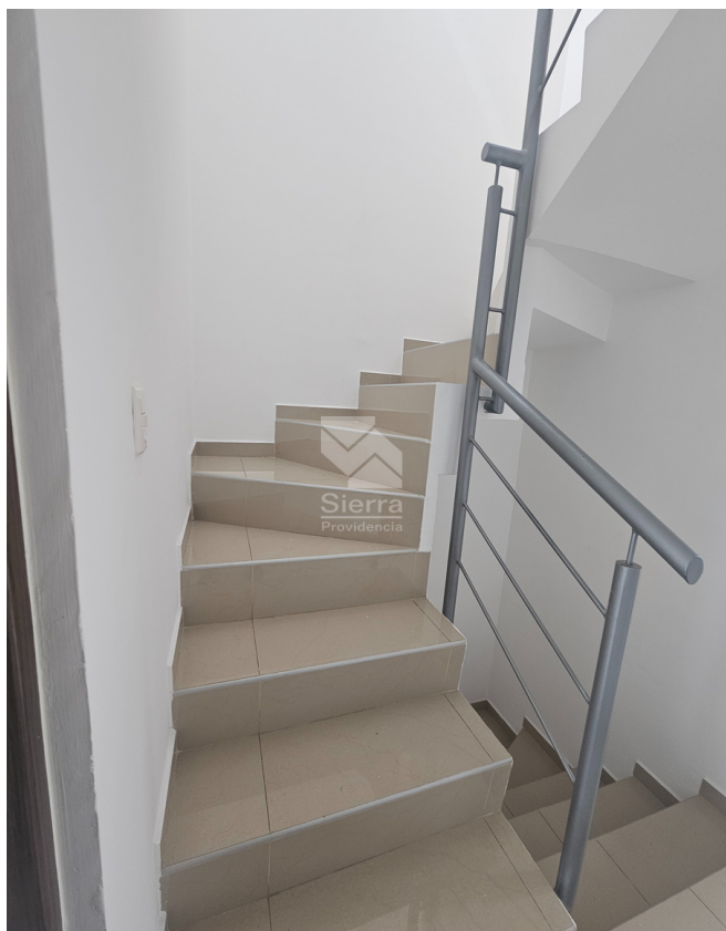
ESCALERAS A 3ER NIVEL
