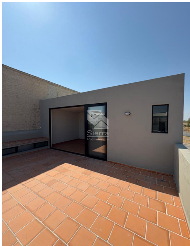
TERRAZA TERCER NIVEL
