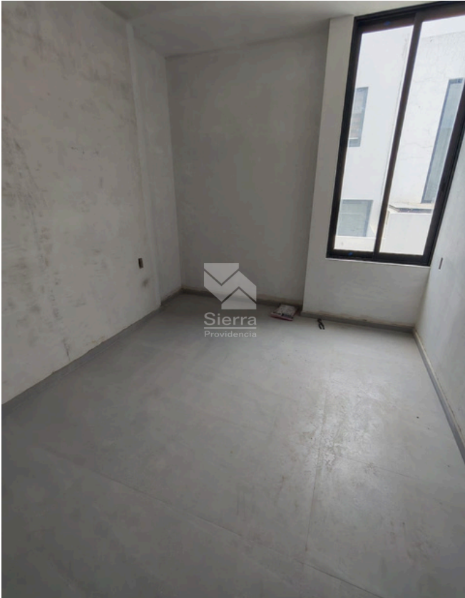
AVANCE DE OBRA
