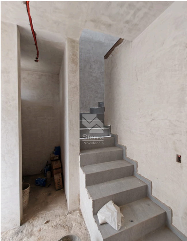
AVANCE DE OBRA
