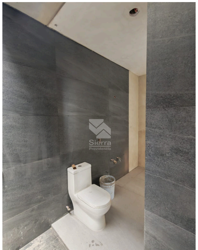
AVANCE DE OBRA
