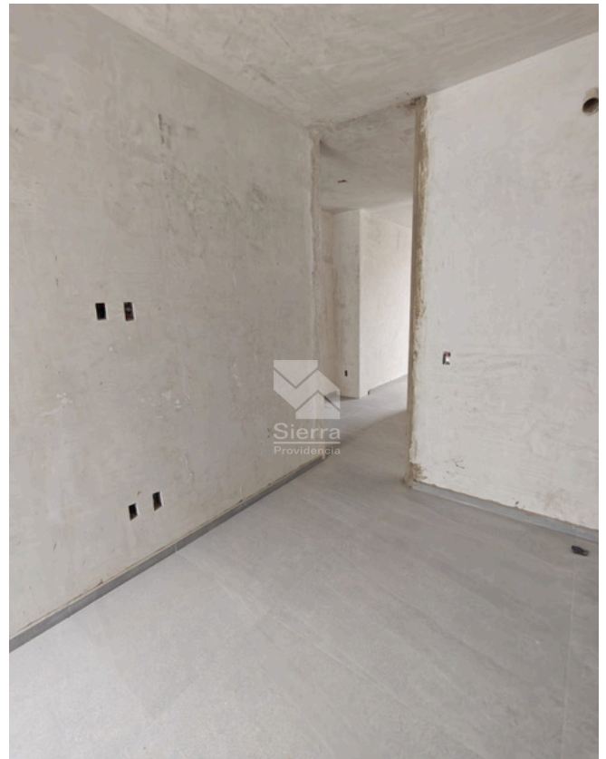
AVANCE DE OBRA
