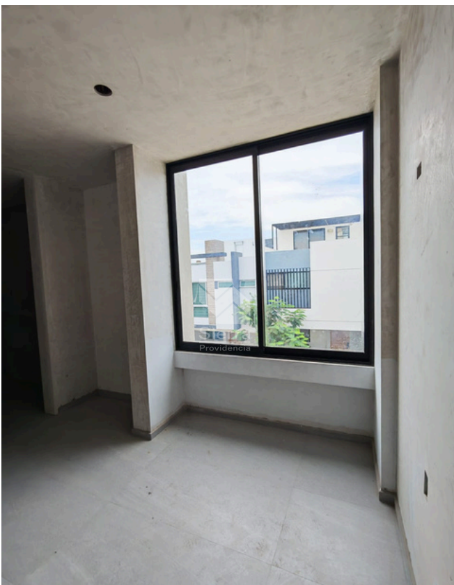
AVANCE DE OBRA
