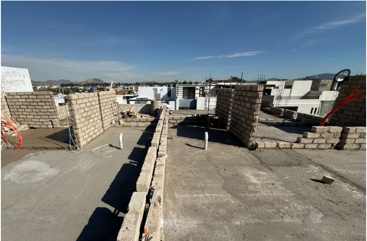
AVANCE DE OBRA
