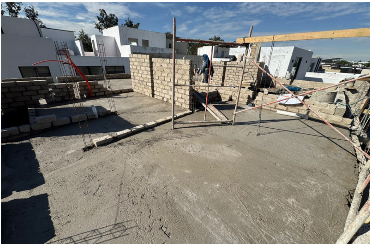
AVANCE DE OBRA
