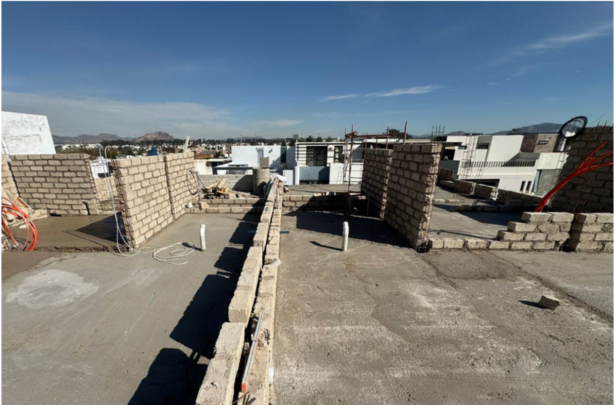
AVANCE DE OBRA
