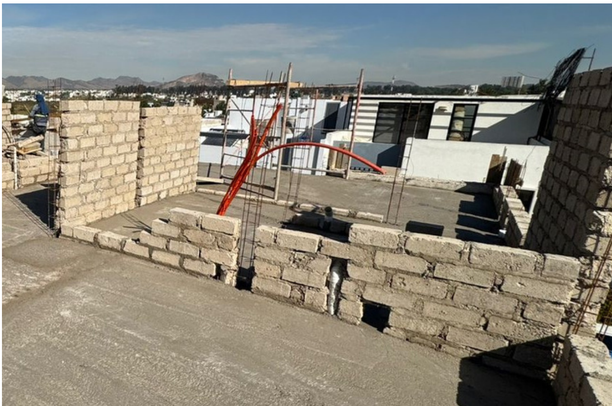
AVANCE DE OBRA
