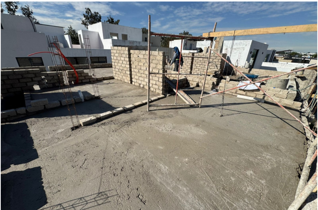
AVANCE DE OBRA
