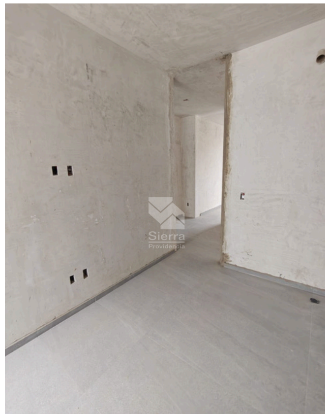
AVANCE DE OBRA
