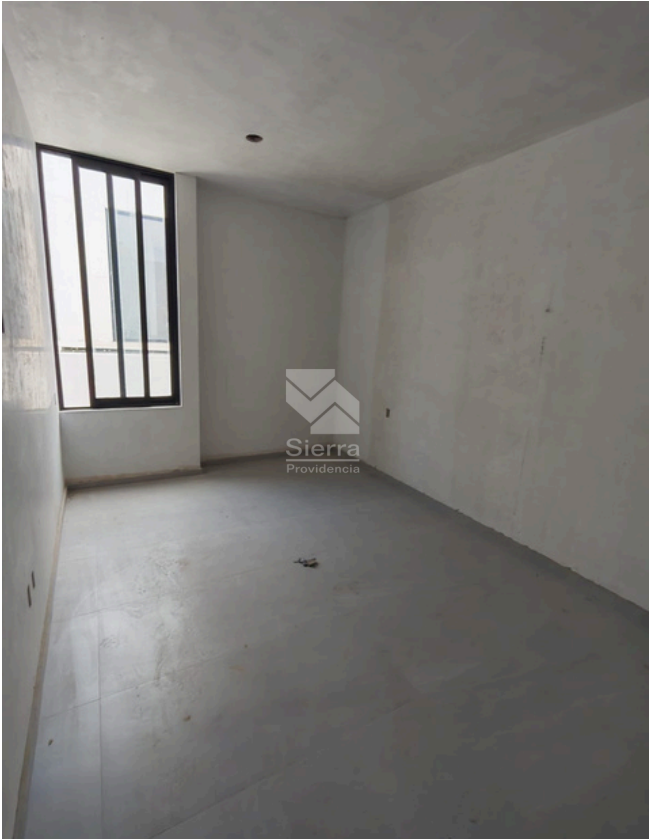
AVANCE DE OBRA
