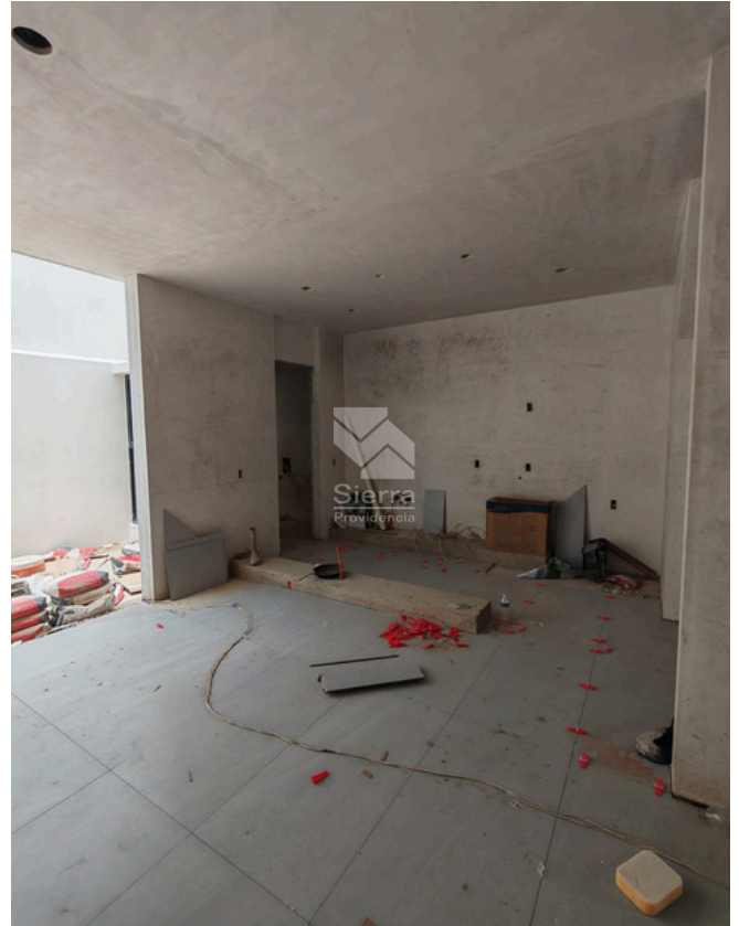
AVANCE DE OBRA
