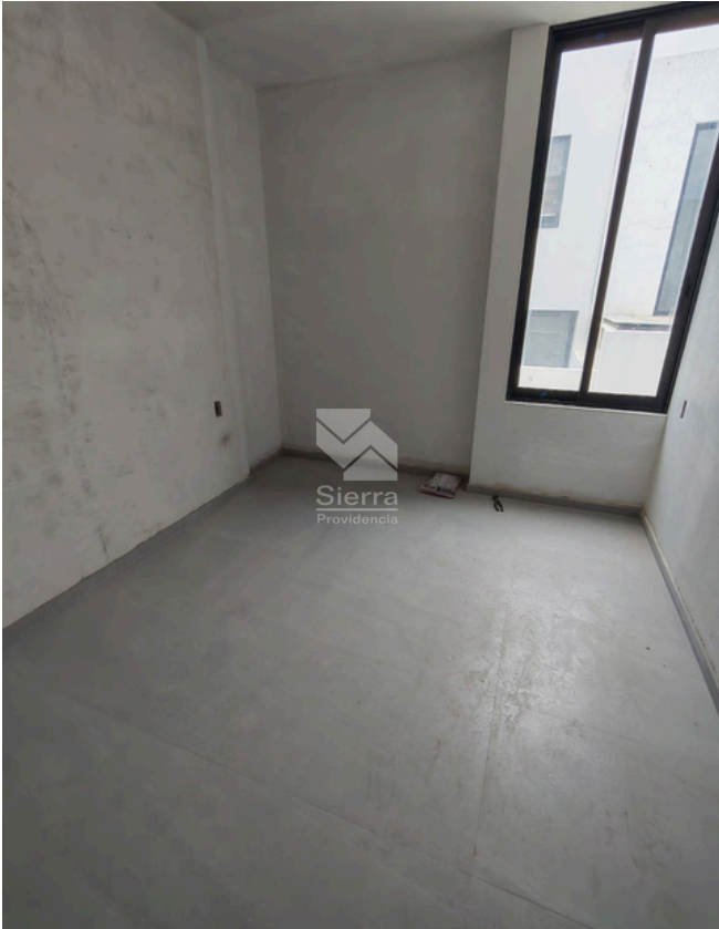
AVANCE DE OBRA
