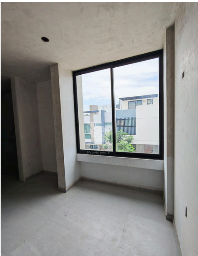
AVANCE DE OBRA
