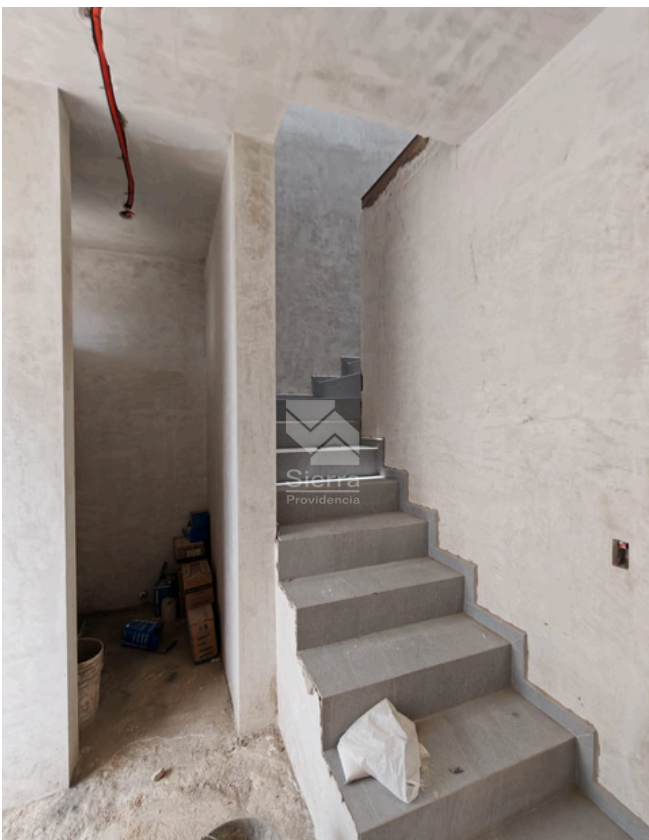
AVANCE DE OBRA
