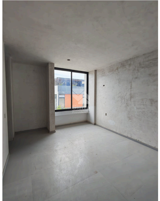
AVANCE DE OBRA
