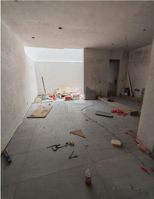
AVANCE DE OBRA
