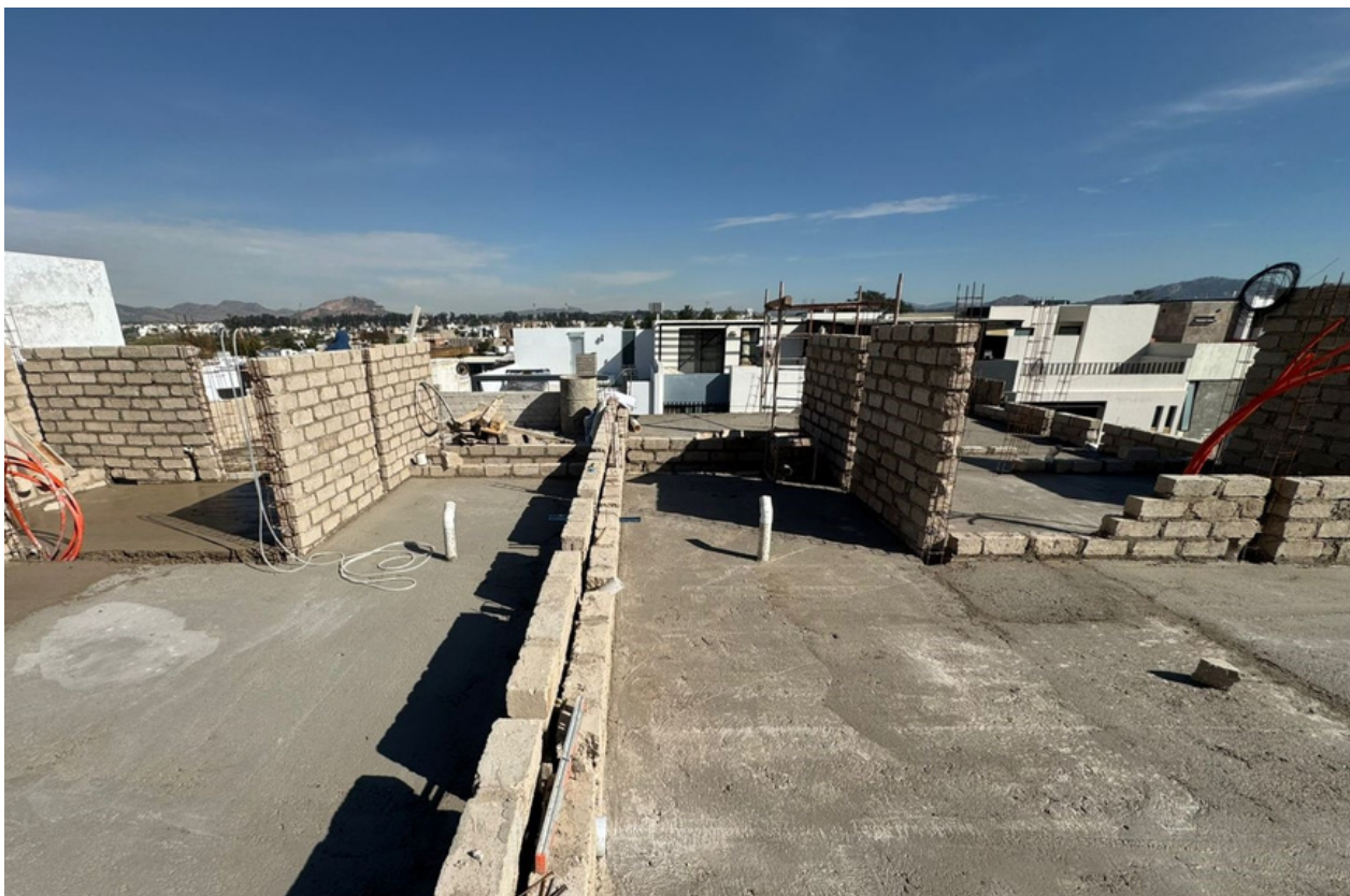
AVANCE DE OBRA
