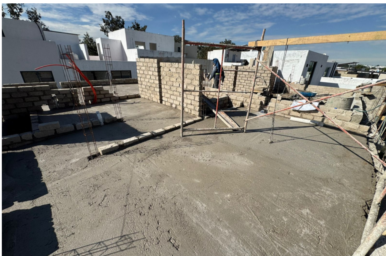
AVANCE DE OBRA
