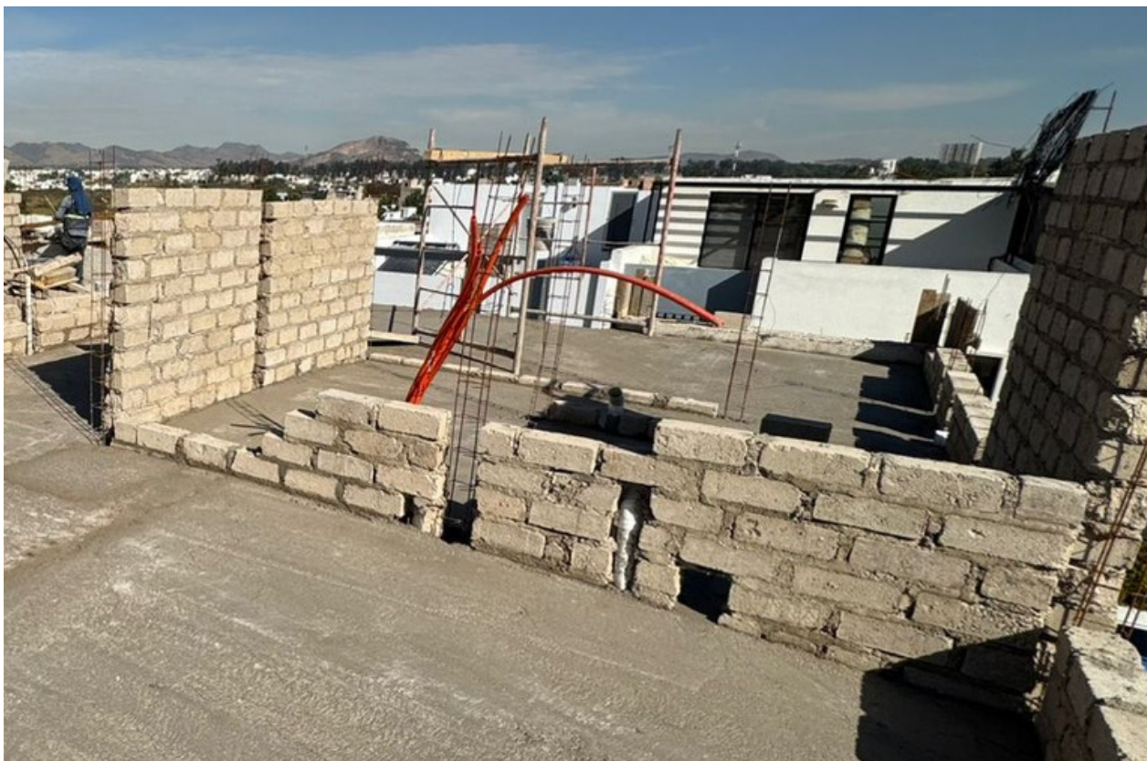
AVANCE DE OBRA
