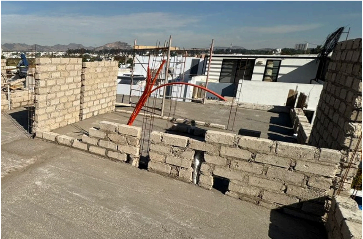
AVANCE DE OBRA
