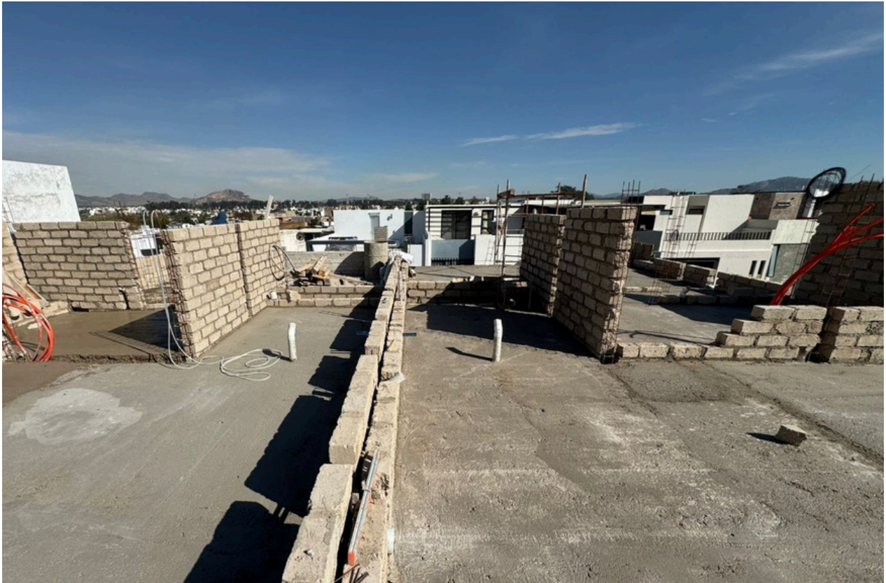
AVANCE DE OBRA
