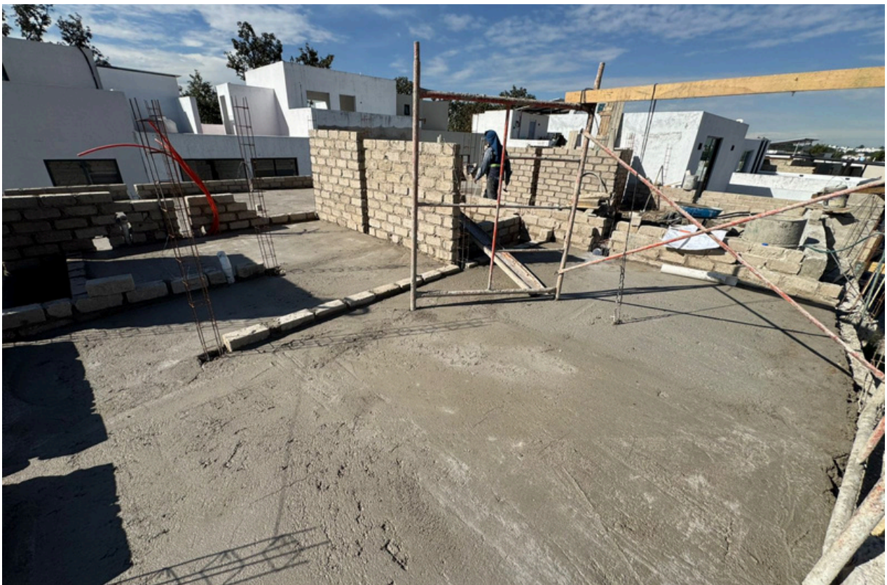
AVANCE DE OBRA
