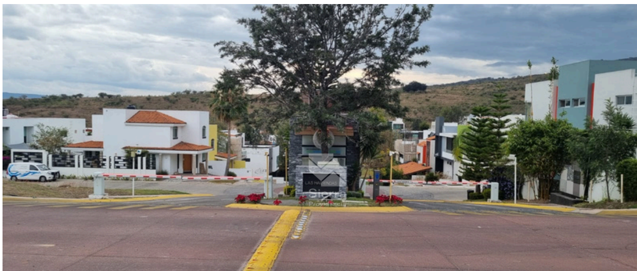
INGRESO A FRACCIONAMIENTO
