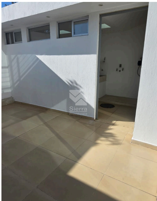
CUARTO DE LAVADO
