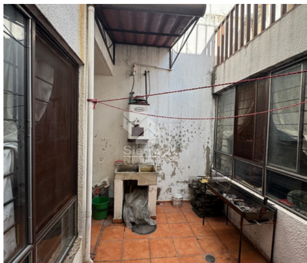
PATIO - ÁREA DE LAVADO
