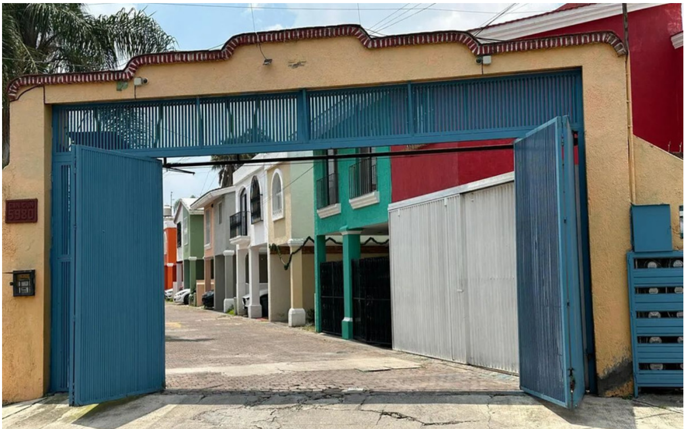
INGRESO A FRACCIONAMIENTO
