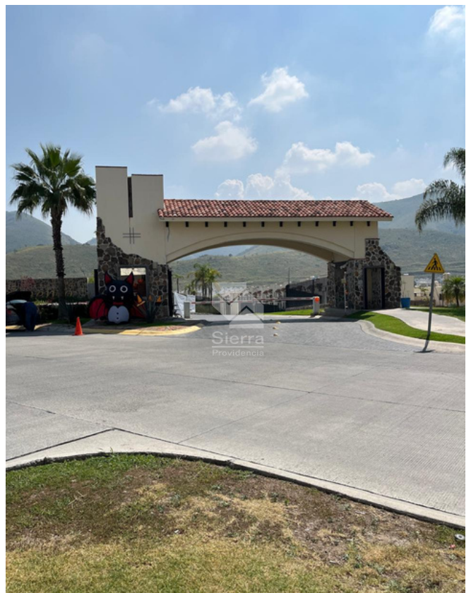
INGRESO A FRACCIONAMIENTO
