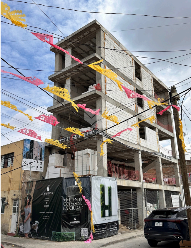
AVANCE DE OBRA EDIFICIO
