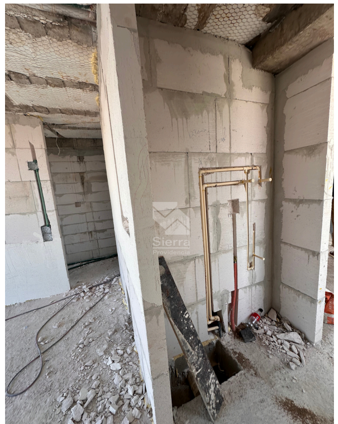
AVANCE DE OBRA PREPARACIÓN DE DUCTOS
