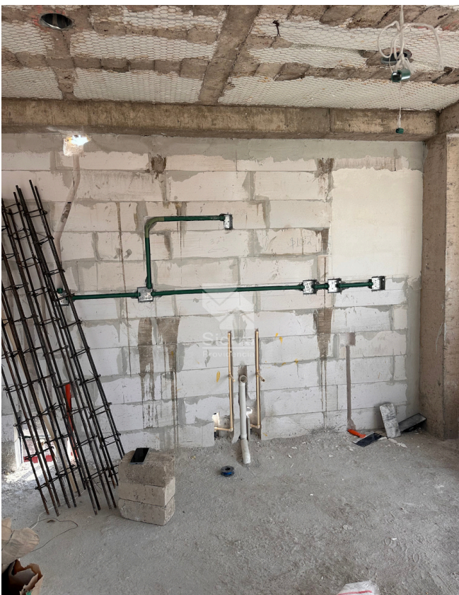
AVANCE DE OBRA COCINA
