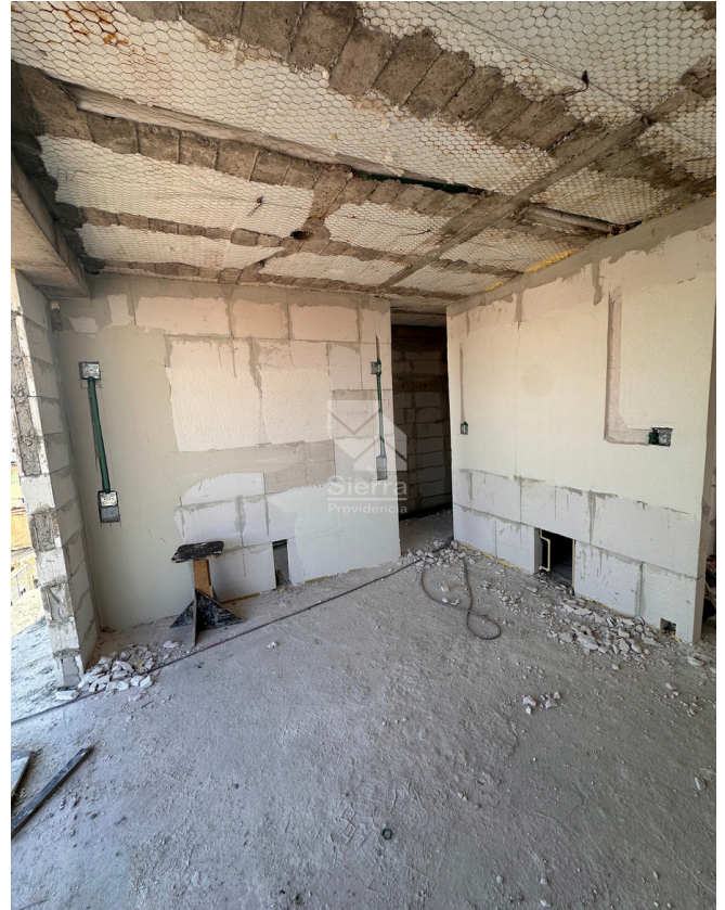
AVANCE DE OBRA RECÁMARA
