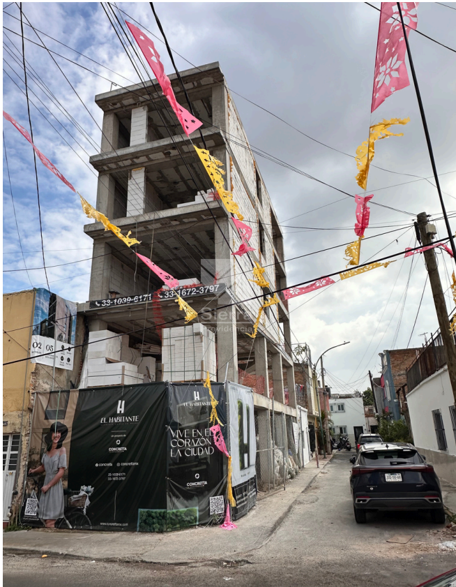
AVANCE DE OBRA EDIFICIO
