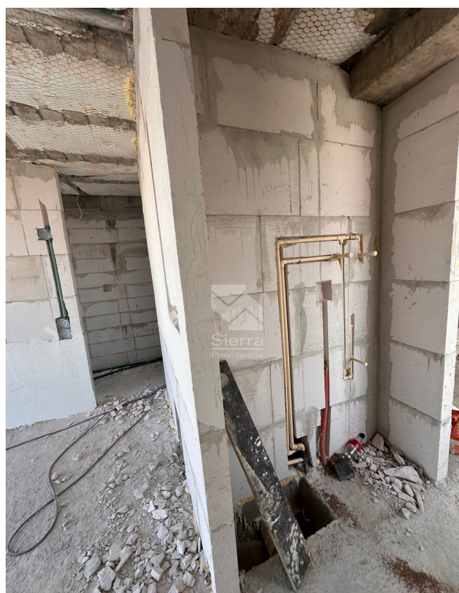
AVANCE DE OBRA PREPARACIÓN DE DUCTOS
