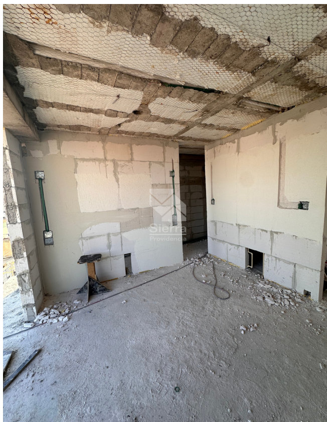
AVANCE DE OBRA RECÁMARA
