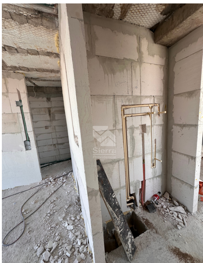
AVANCE DE OBRA PREPARACIÓN DE DUCTOS
