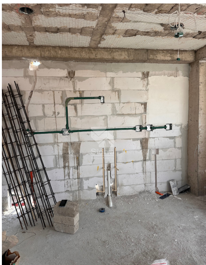
AVANCE DE OBRA COCINA
