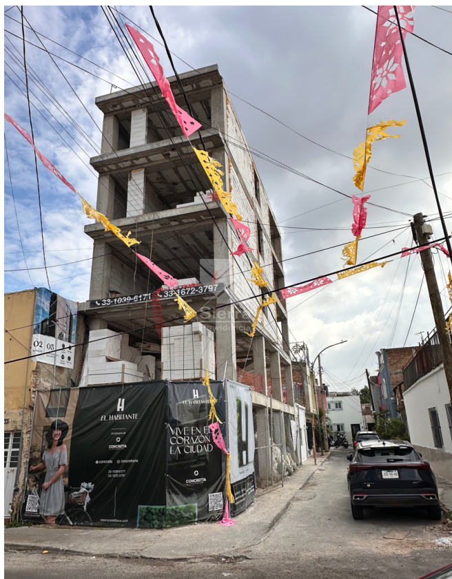
AVANCE DE OBRA EDIFICIO
