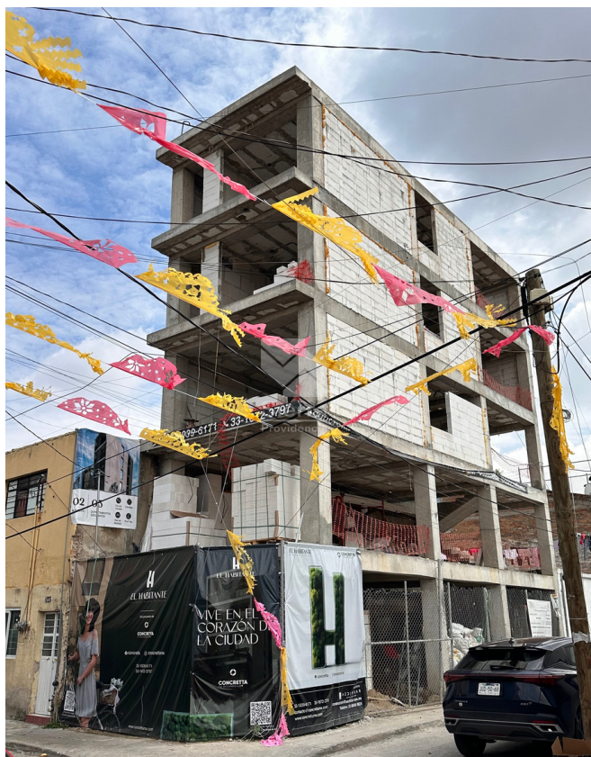
AVANCE DE OBRA EDIFICIO
