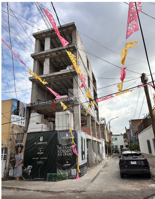
AVANCE DE OBRA EDIFICIO
