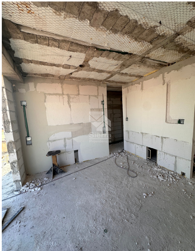
AVANCE DE OBRA RECÁMARA
