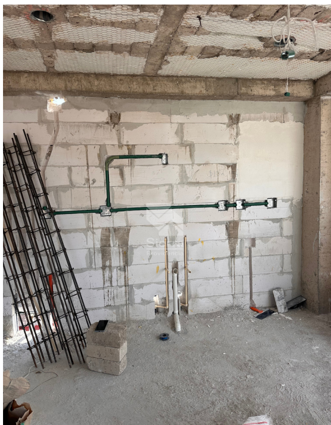
AVANCE DE OBRA COCINA
