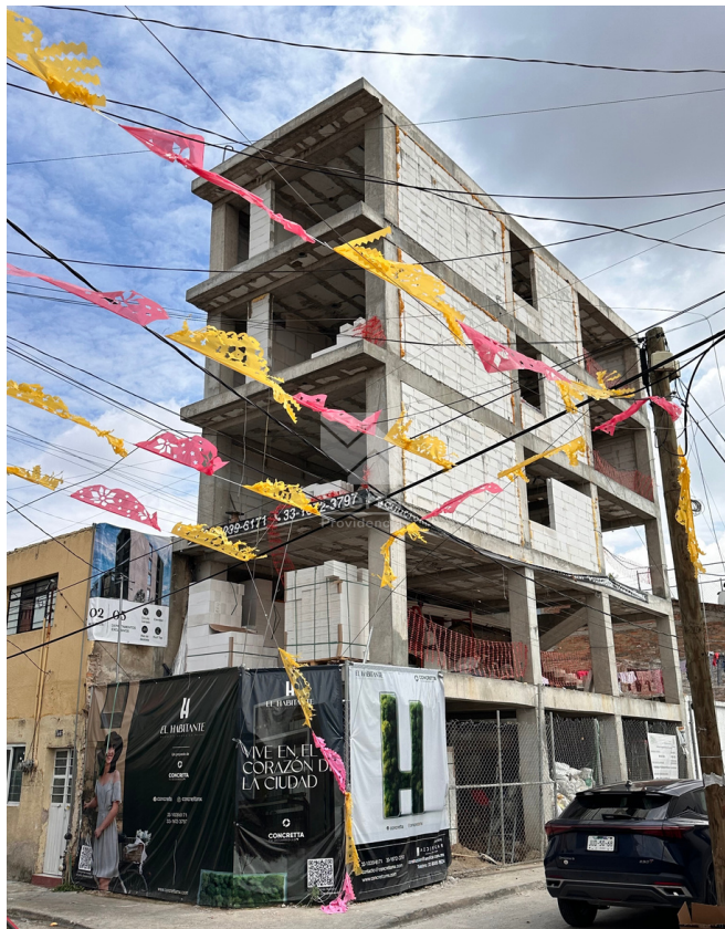
AVANCE DE OBRA EDIFICIO
