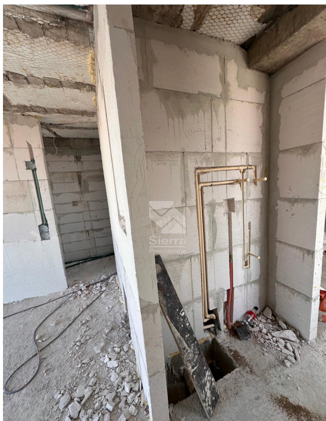
AVANCE DE OBRA PREPARACIÓN DE DUCTOS
