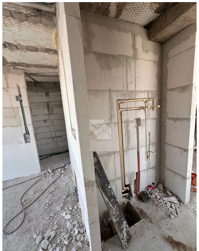
AVANCE DE OBRA PREPARACIÓN DE DUCTOS
