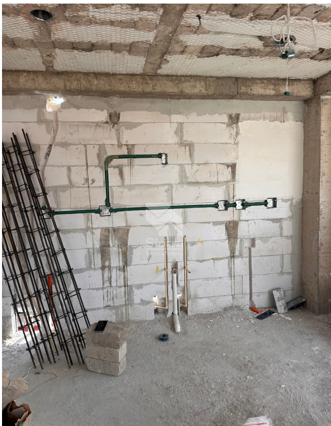
AVANCE DE OBRA COCINA
