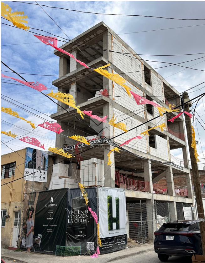
AVANCE DE OBRA EDIFICIO
