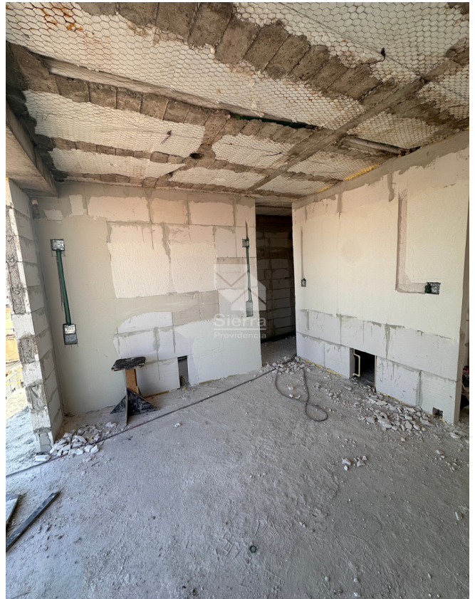
AVANCE DE OBRA RECÁMARA
