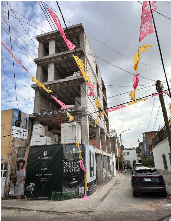
AVANCE DE OBRA EDIFICIO
