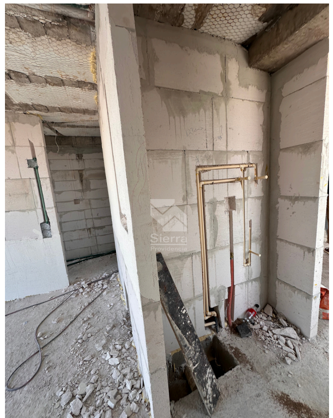
AVANCE DE OBRA PREPARACIÓN DE DUCTOS
