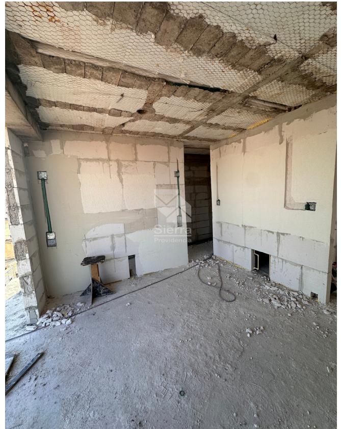
AVANCE DE OBRA RECÁMARA
