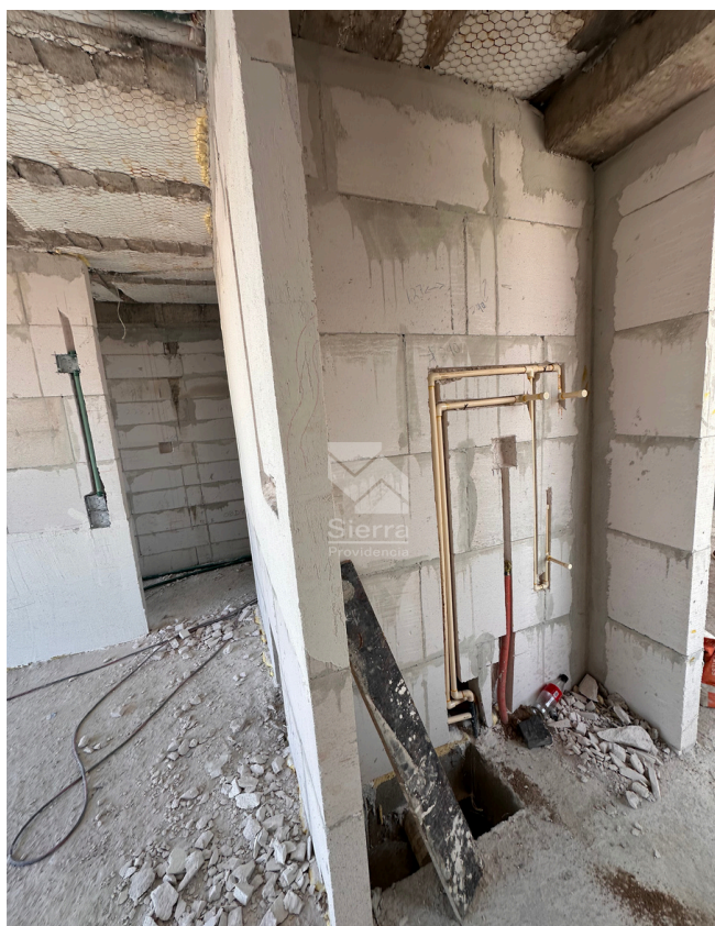
AVANCE DE OBRA PREPARACIÓN DE DUCTOS
