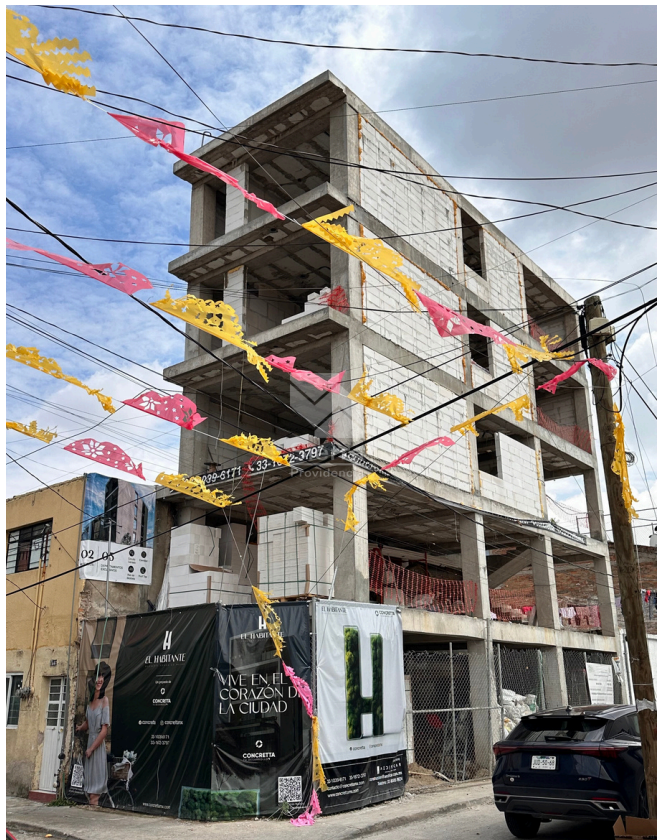
AVANCE DE OBRA EDIFICIO
