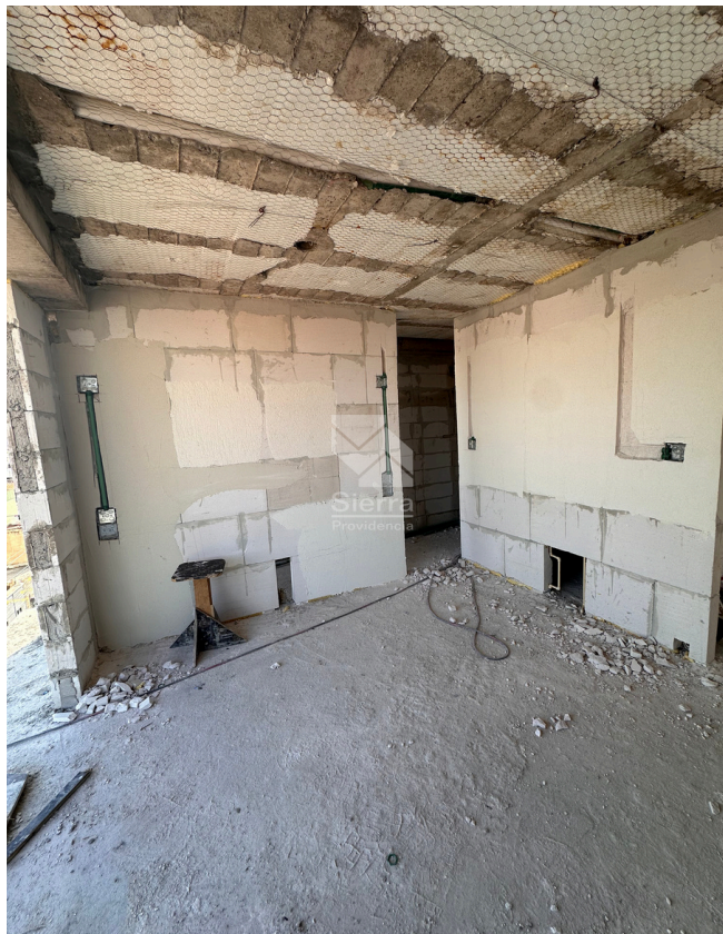
AVANCE DE OBRA RECÁMARA
