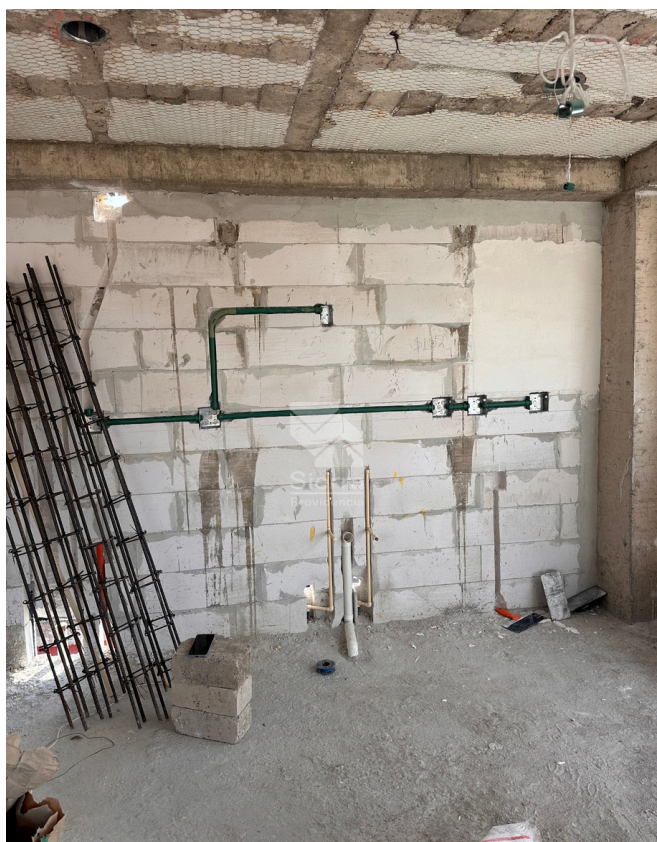
AVANCE DE OBRA COCINA
