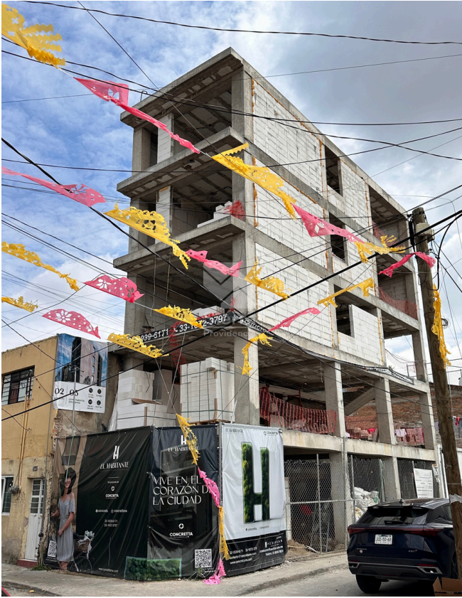
AVANCE DE OBRA EDIFICIO
