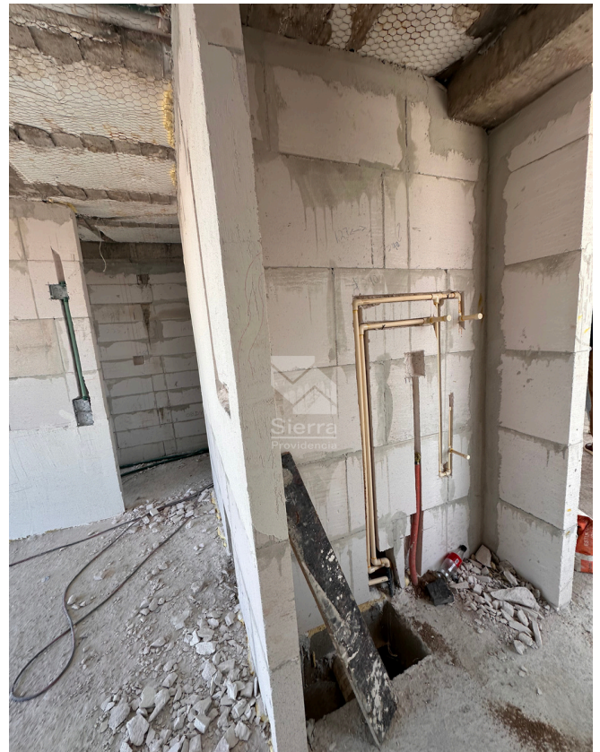
AVANCE DE OBRA PREPARACIÓN DE DUCTOS
