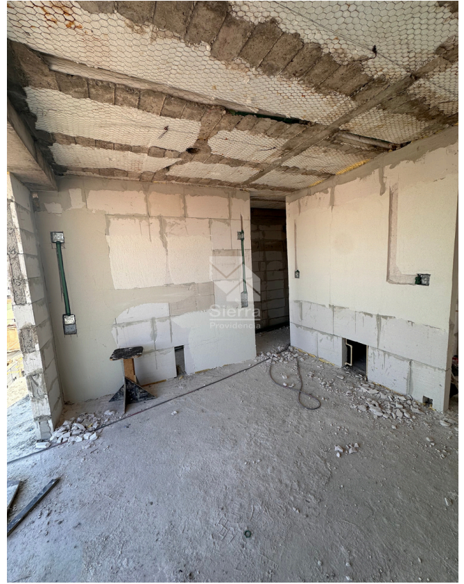
AVANCE DE OBRA RECÁMARA
