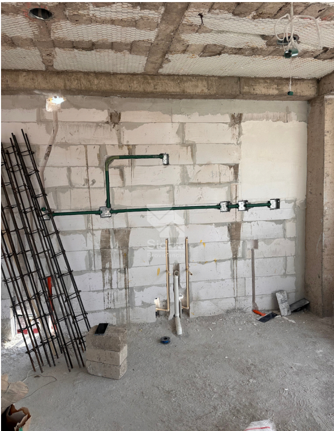
AVANCE DE OBRA COCINA
