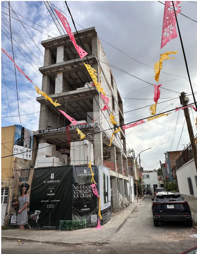
AVANCE DE OBRA EDIFICIO
