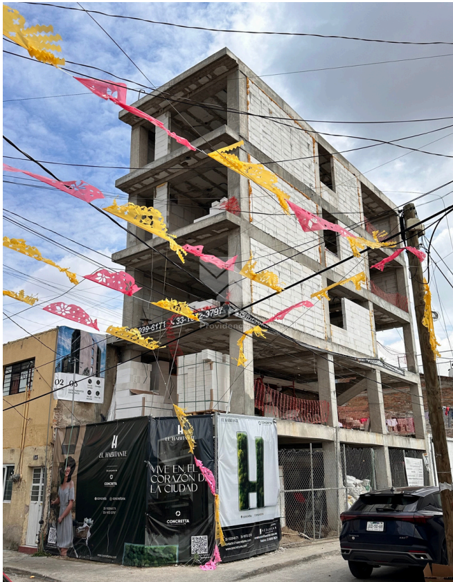
AVANCE DE OBRA EDIFICIO
