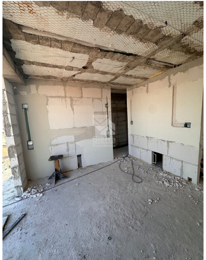
AVANCE DE OBRA RECÁMARA
