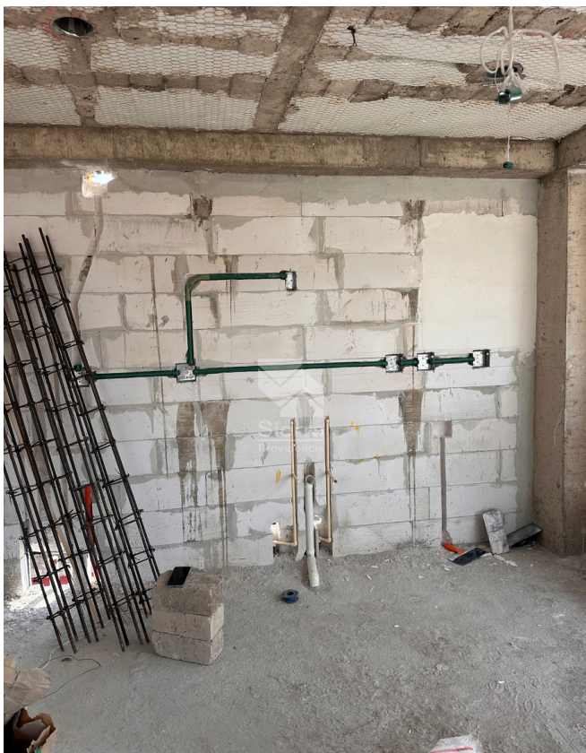
AVANCE DE OBRA COCINA
