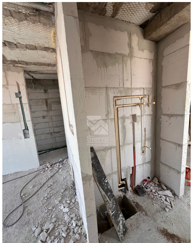
AVANCE DE OBRA PREPARACIÓN DE DUCTOS
