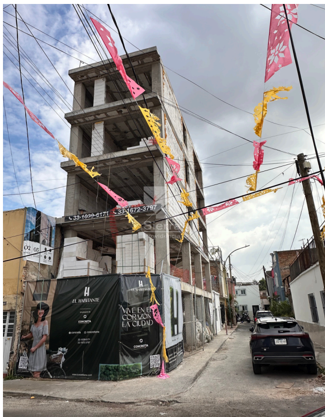
AVANCE DE OBRA EDIFICIO
