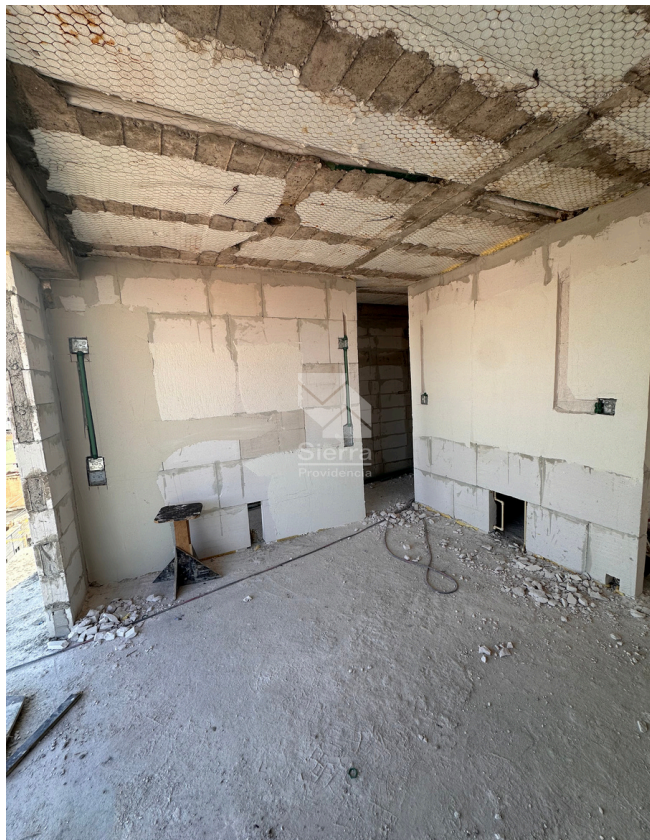
AVANCE DE OBRA RECÁMARA
