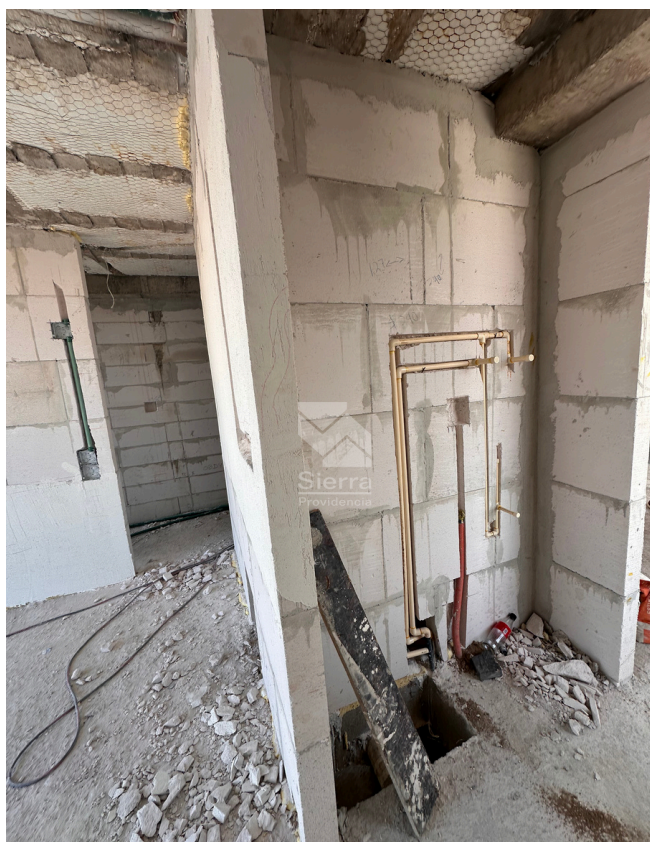
AVANCE DE OBRA PREPARACIÓN DE DUCTOS
