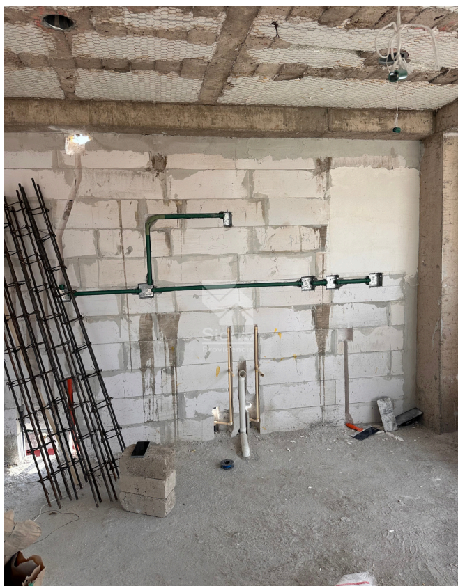
AVANCE DE OBRA COCINA
