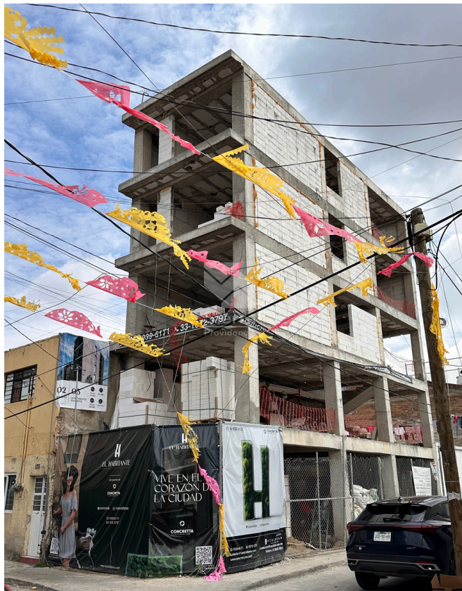
AVANCE DE OBRA EDIFICIO
