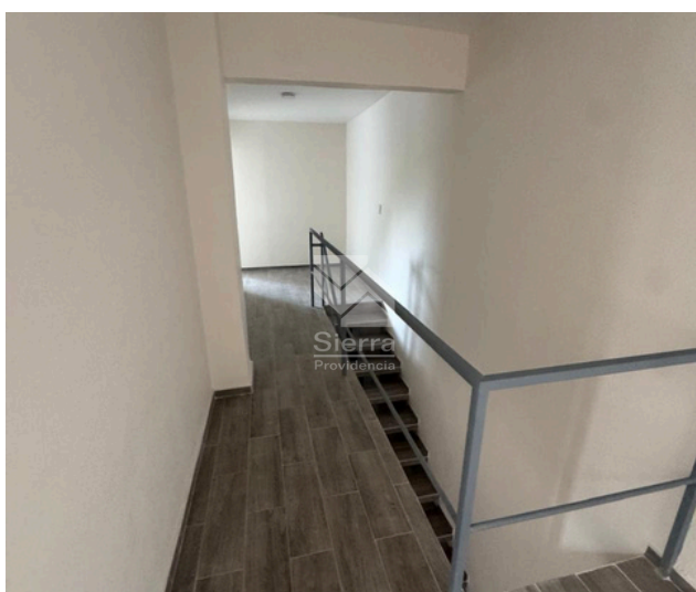
PASILLO DISTRIBUCIÓN SEGUNDO NIVEL
