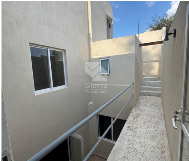
PASILLO TERCER NIVEL
