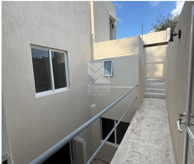
PASILLO TERCER NIVEL
