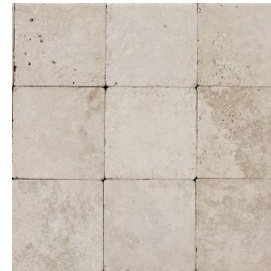
Muro de concreto con recubrimiento de mármol fiorito 10x10cm
